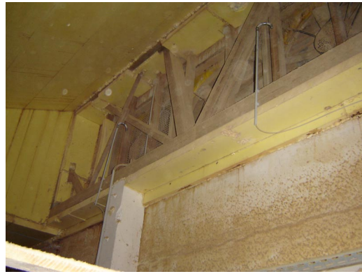
Abb. 12: Gasmessposition Monoschacht Boden II
