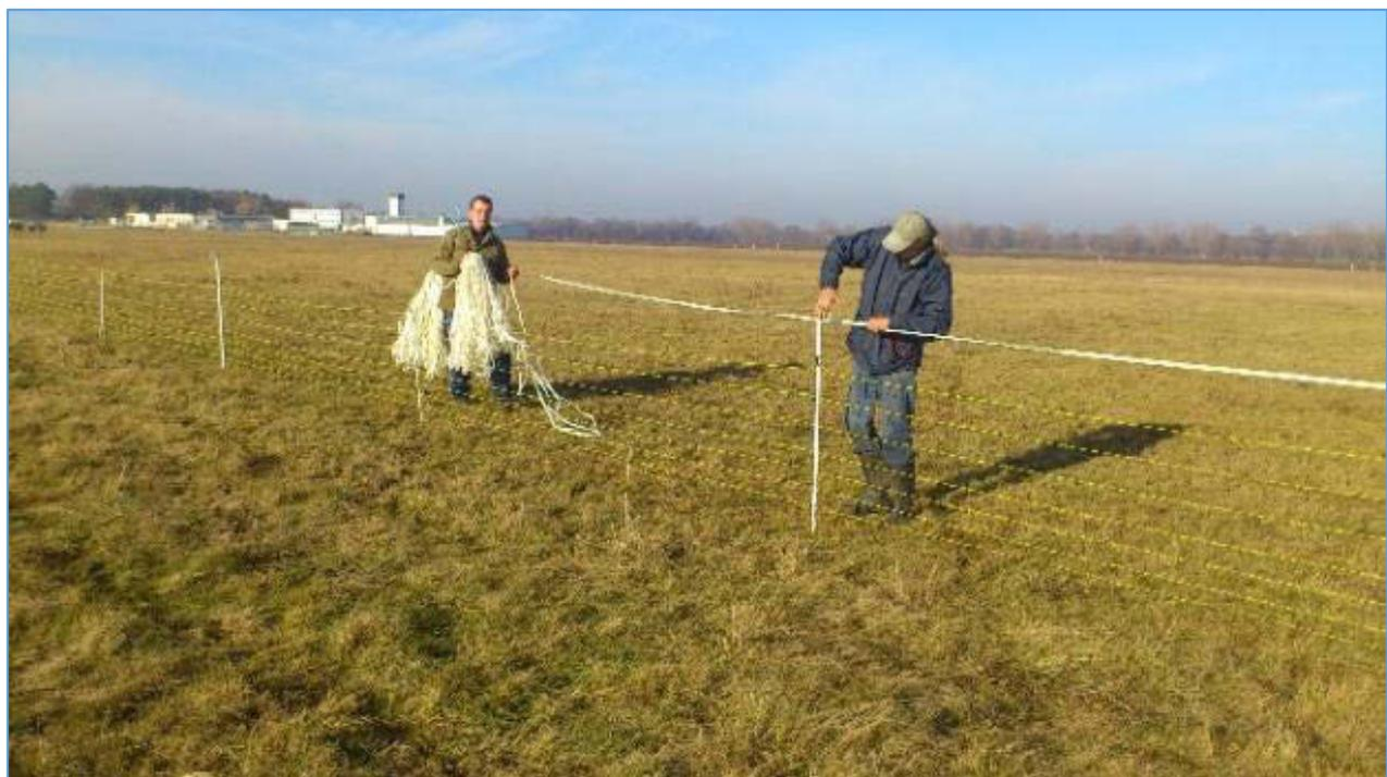
**Abbildung 21: Stecken der Pfähle, Anbringen des Elektrozaunbandes**
