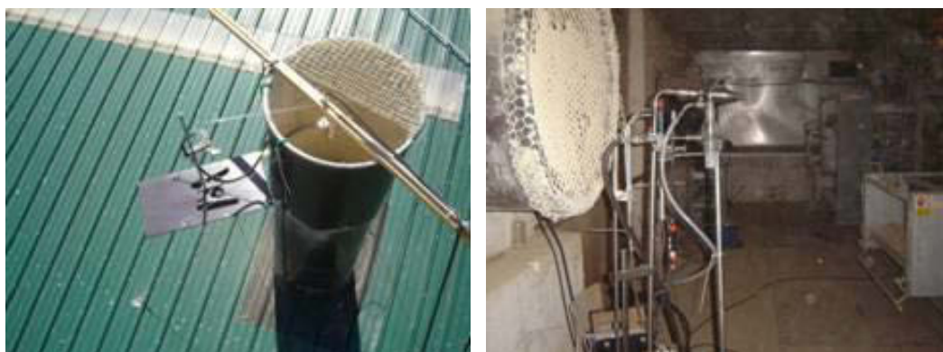
Abbildung 7: Probennahmepunkte für Staub und Keime am Dach- (links) bzw. Wandkamin (rechts)
