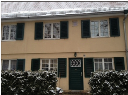
Günther Eulitz aus Hellerau trocknet das Gemäuer seines Reihenhauses kreativ, ohne Bauaufwand und erfolgreich mit dem patentierten Matrolan. Service und Einbau realisierte die Firma Groß aus Struppen, bei Pirna.
