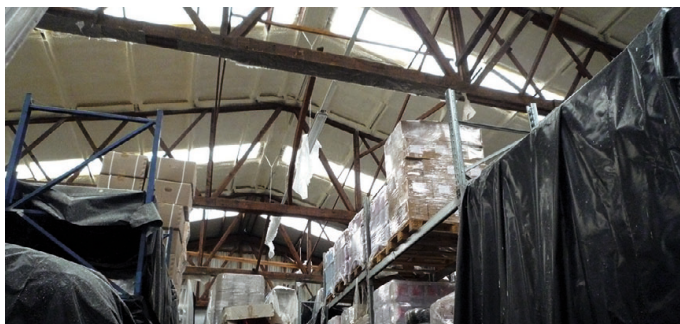
Sprühschaum-Dämmung – wie hier unter dem Dach einer Firma bei Wurzen – spart im Winter Heizenergie. Im Sommer schützt sie Mensch und Material vor Überhitzung. Problemlos haftet sie auf fast jedem Untergrund.
