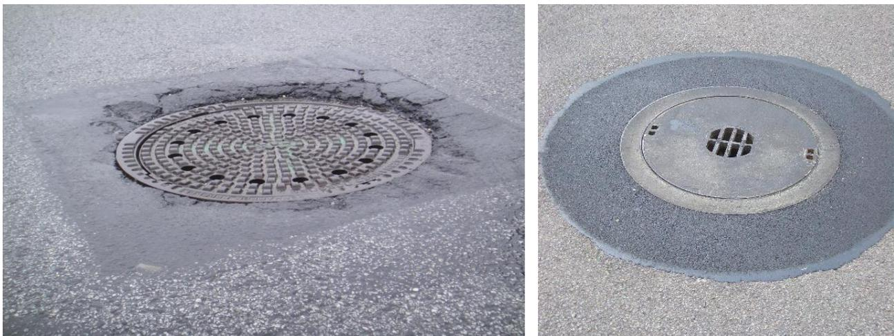
**Abbildung 27a/b: schadhafte Schachtabdeckung/ „Flüsterdeckel“**
