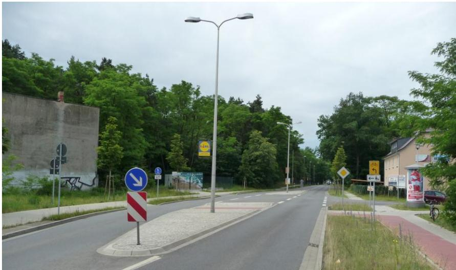
**Abbildung 23: Ortseingangssituation mit Mittelinsel zur Geschwindigkeitsdämpfung (Saarbrücker Straße, Cottbus)**
