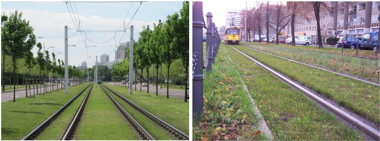
**Abbildung 26a/b: Rasengleis mit tief liegendem (Halle/Saale) und hoch liegendem Vegetationssystem (Dresden)**
