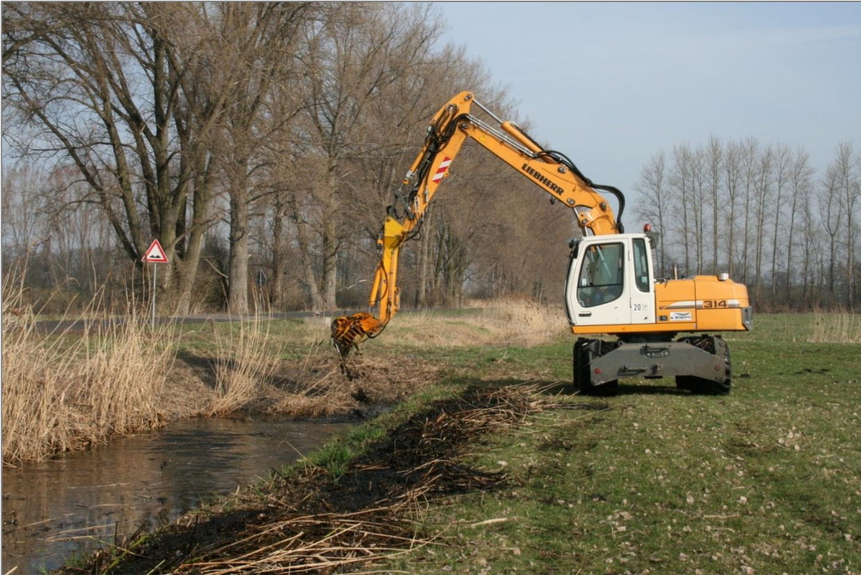
Abbildung 2-20: Unterhaltungsmaßnahme „Sohlkrautung“ am Gewässer II. Ordnung, Brandenburg (Foto: Bosch & Partner)
