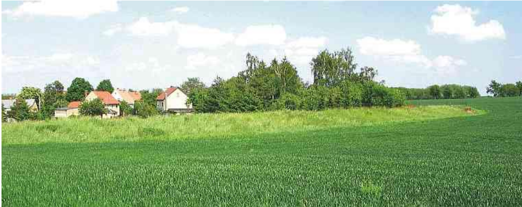
Abbildung 33: Landwirtschaftlicher Rückhaltedamm Barnitz, Blick aus Richtung Feld
