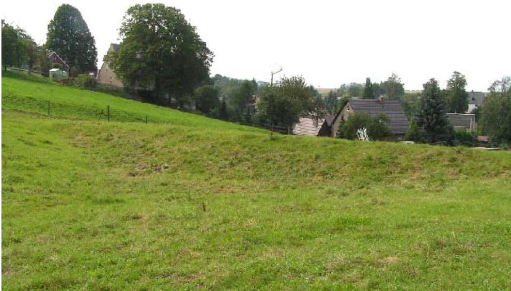
Abbildung 19: Rückhaltedämme in Niederfrohna 117
