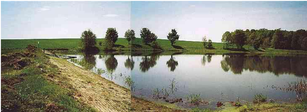
Abbildung 34: Kleinspeicher Holtendorf, Blick in Richtung Süden mit Entnahmebauwerk
