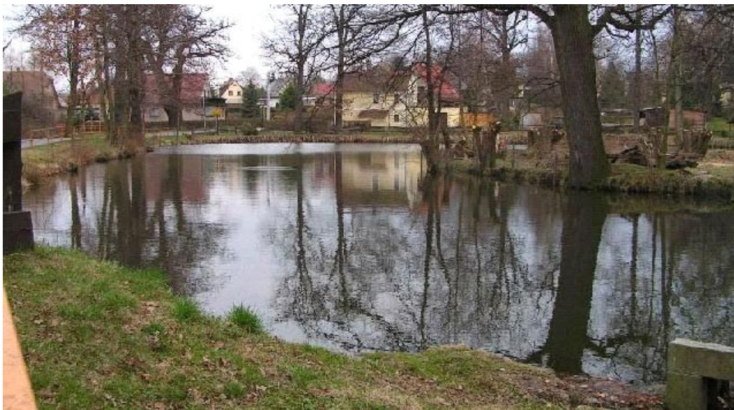
Abbildung 28: Der Mühlteich Günthersdorf nach der Sanierung 131
