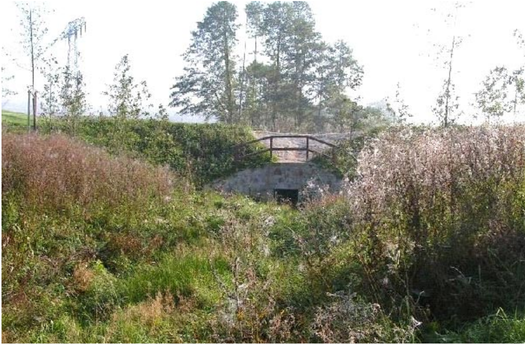
Abbildung 24: Hochwasserrückhaltungsdamm „Fischers Reuth“ 126
