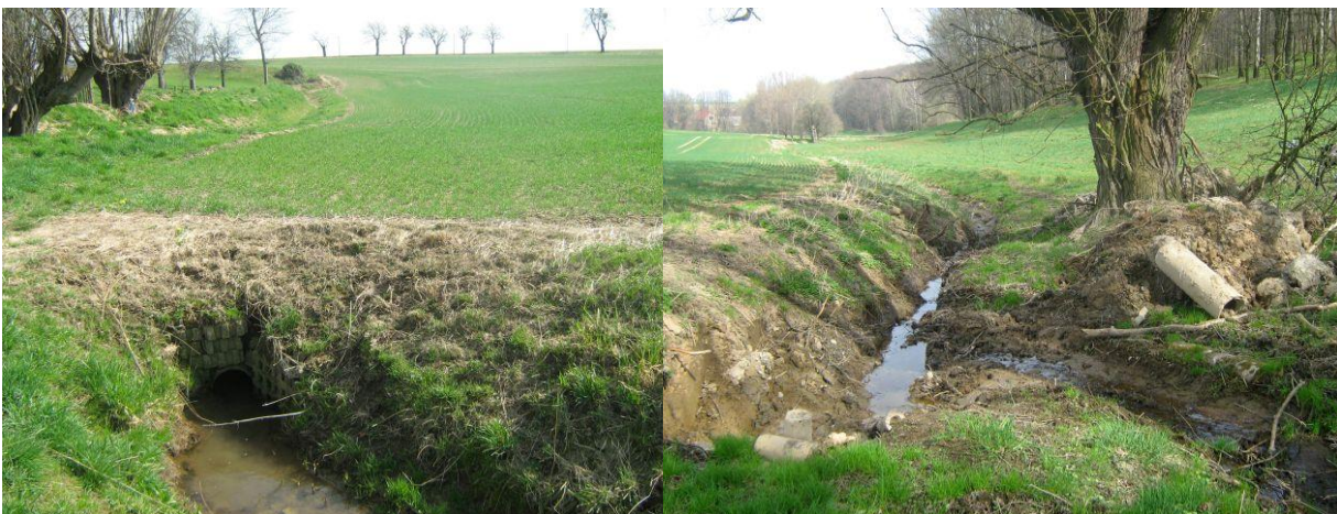
Abbildung 4: a) Verrohrter Bach unter Acker in Luga bei Meißen (links) b) Geöffnete Verrohrung oberhalb von Kaschka bei Meißen
