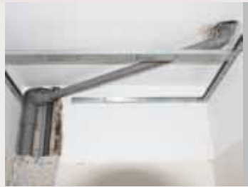
Am Anfang standen umfassende Abbrucharbeiten. Leitungen und Rohre wurden dem neuen Grundriss entsprechend verlegt. Die neuen Badmöbel wurden an ihrem Bestimmungsort montiert.
