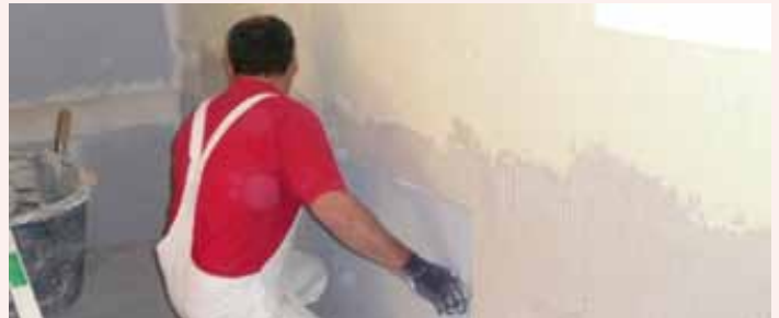
Schimmelfrei in wenigen Schritten: Die Calciumsilikatplatten nehmen überschüssige Feuchtigkeit auf und geben sie nach und nach wieder ab. Die Verklebung der Platten ist unkompliziert realisierbar.
