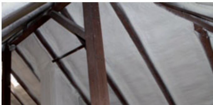
Sprühschaum-Dämmung – wie hier unterm Dach – bewährt sich nicht nur in Wohnhäusern. Auch in gewerblichen Gebäuden wie Hallen, Werkstätten und sogar in Biogasanlagen findet sie Anwendung. Der Untergrund kann völlig uneben sein.
