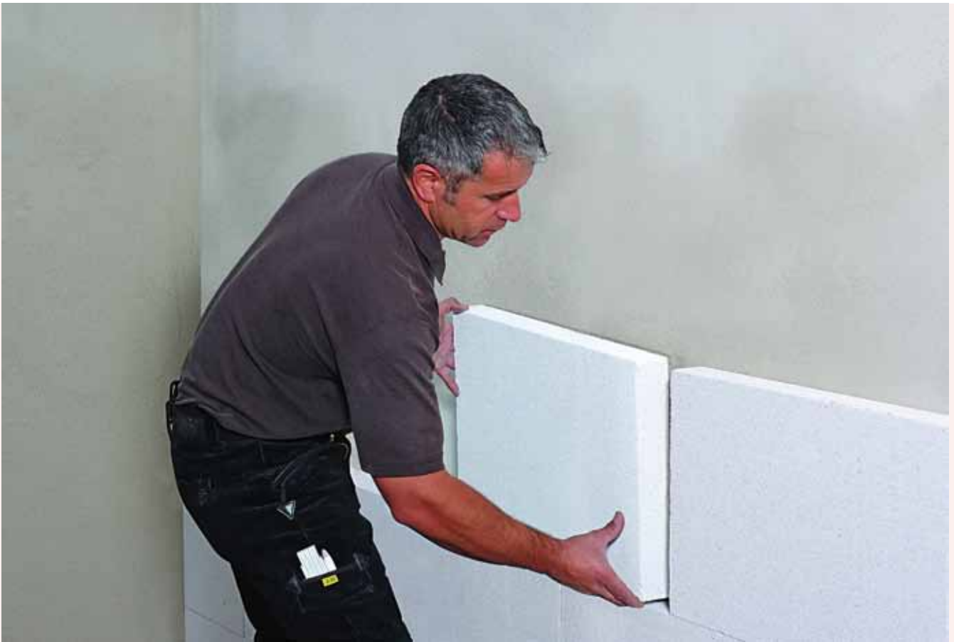
Keller mit Innendämmung: auch als Wohnraum nutzbar.
