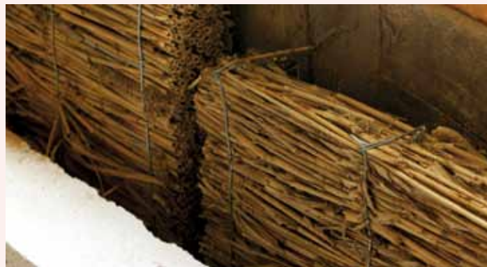
Dämmungsaufbau einer Innenwand mit Strohmaten.
