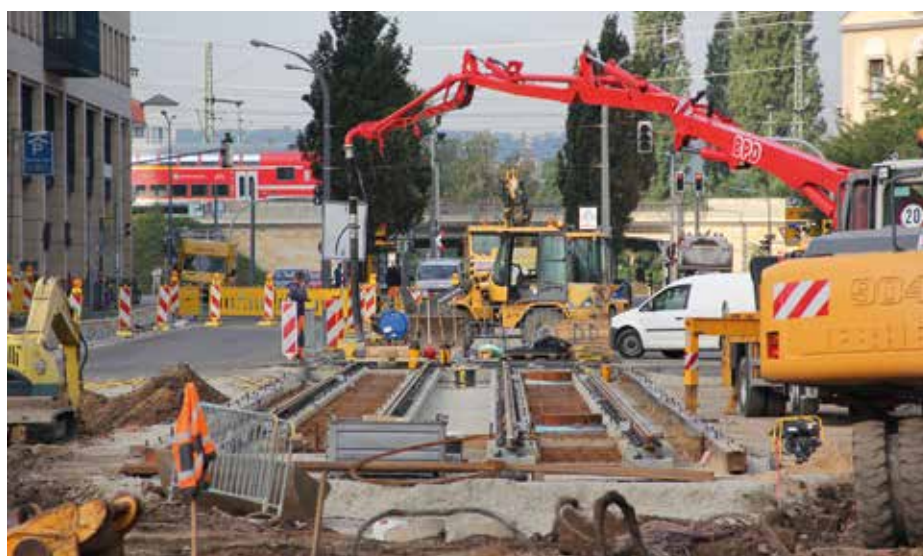
Baustelle Freiburger Straße: 2011 hat die DVB hier in neue Gleis- und Bahnstromanlagen investiert.
