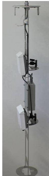
Abbildung 27: Antennenrohr im Melkstand
