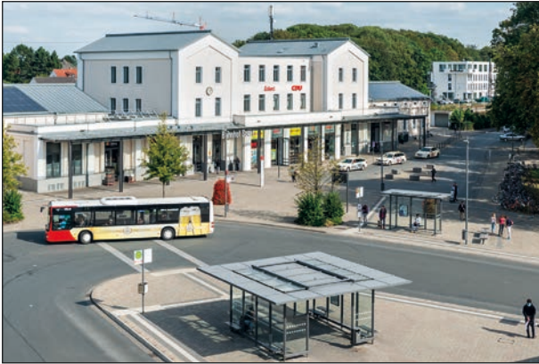
Abb. 3: Empfangsgebäude und Vorplatz am Bahnhof Soest (Foto: Stefan Klink, BEG NRW)
