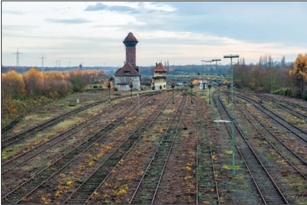
Abb. 1: Entwicklungsfläche Duisburg-Wedau vor Rückbau (Foto: Stefan Klink, BEG NRW)
