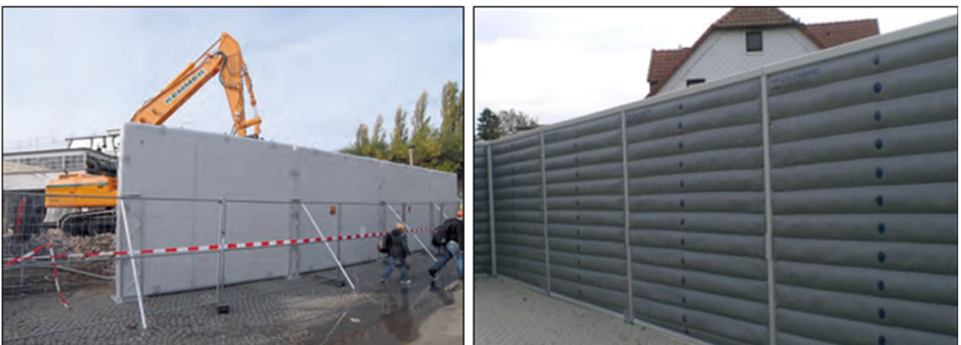
Abbildung 28: Beispielansichten mobiler Schallschutzwände; links: Ceno Wall (Foto:Sattler Global/Ceno Tec), rechts: Cisilent (Foto: Calenberg Ingenieure)
