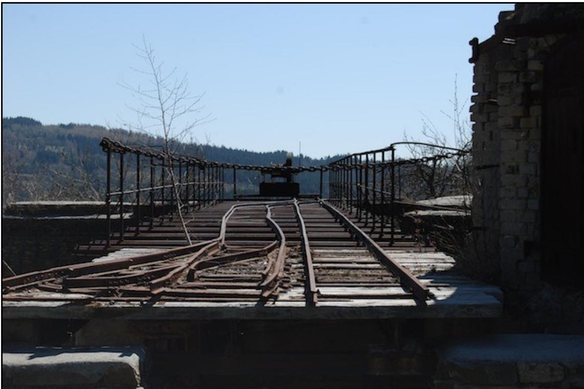
Die Stahlkonstruktion sieht noch ganz gut aus, aber die Beplankung fehlt. Betreten ist **nicht angeraten!** Im Hintergrund sieht man die Umlenkrolle der Seilzuganlage, mit der die Hunte auf die Brücke gezogen werden konnten.
