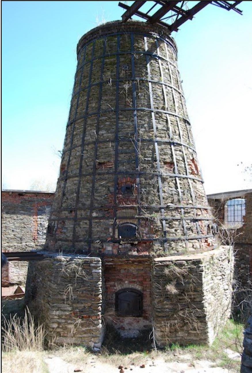
Sie sind konisch aufgezogen und wurden trotz des schweren Bruchsteinmauerwerks noch mit einem ganzen Netz von eisernen Reifen stabilisiert.
