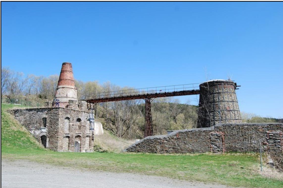
Die beiden neueren Brennöfen vom Hilke'schen Typ hat man wohl deshalb in so auffällig großem Abstand zu dem alten errichtet, um das Gefälle des Hanges dafür auszunutzen, die Hunte ohne Steigung bis zur Gicht der Öfen ziehen zu können.
