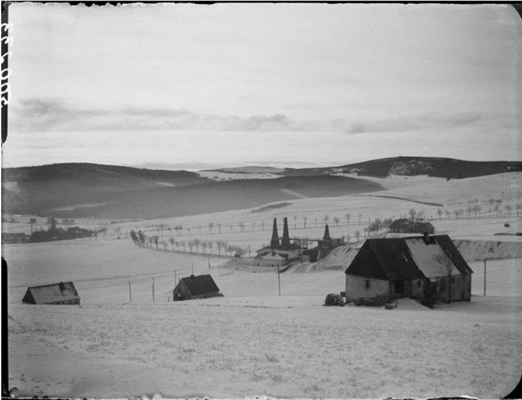
Blick auf Hammerunterwiesenthal, in der Bildmitte das staatliche Kalkwerk mit drei Brennöfen, links die beiden zuletzt erbauten Hilke'schen, noch mit hohen Schornsteinaufsätzen versehen, wie bei dem Typ der Hofmann'schen Schachtöfen, Foto C. Langer, um 1930.
