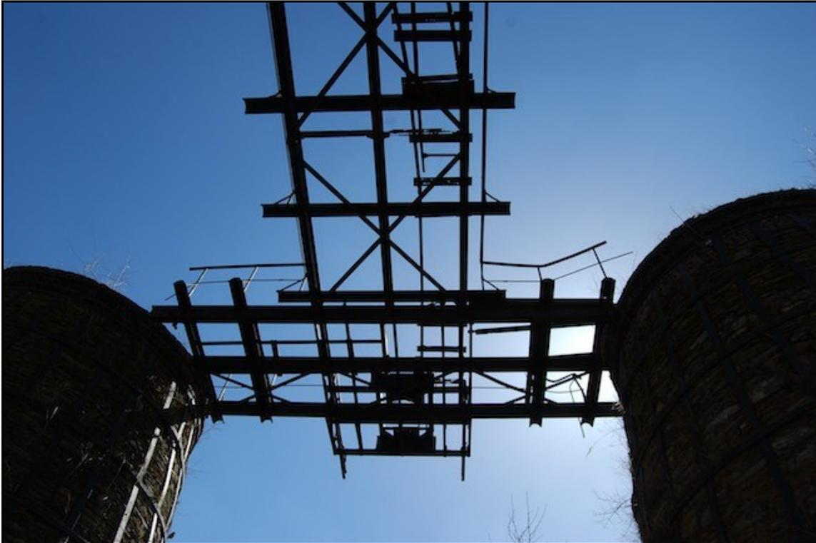
Das Ende der Förderbrücke ist T-förmig gebaut. Bis hier hin ging es maschinell, dann mußten die Ofenarbeiter die Hunte drehen und in die Brennschächte entleeren. Paarweise hat man sie sicher errichtet, um bei Reparaturen am einen den anderen trotzdem in Betrieb und damit die Produktion aufrechterhalten zu können.
