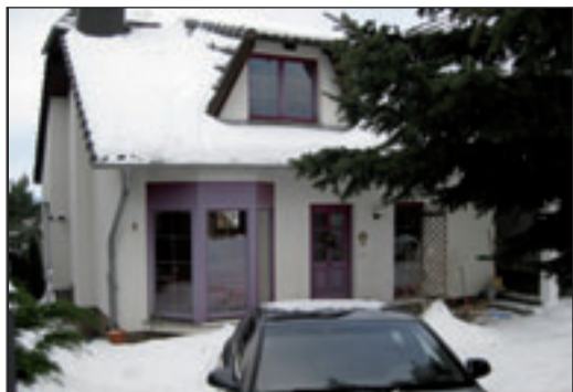
Aufsteigende Nässe und eine stets feuchte Bodenplatte im Haus plagte bis Ende 2010 Familie Franz aus Weinböhla. Ohne massiven Bauaufwand bekam sie das Problem dauerhaft in den Griff.
