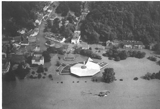
Abb. 1: Das Hochwasser 2002 im Engtal der Elbe in der Sächsischen Schweiz – hier in Bad Schandau (Foto: R. Heselbarth)
