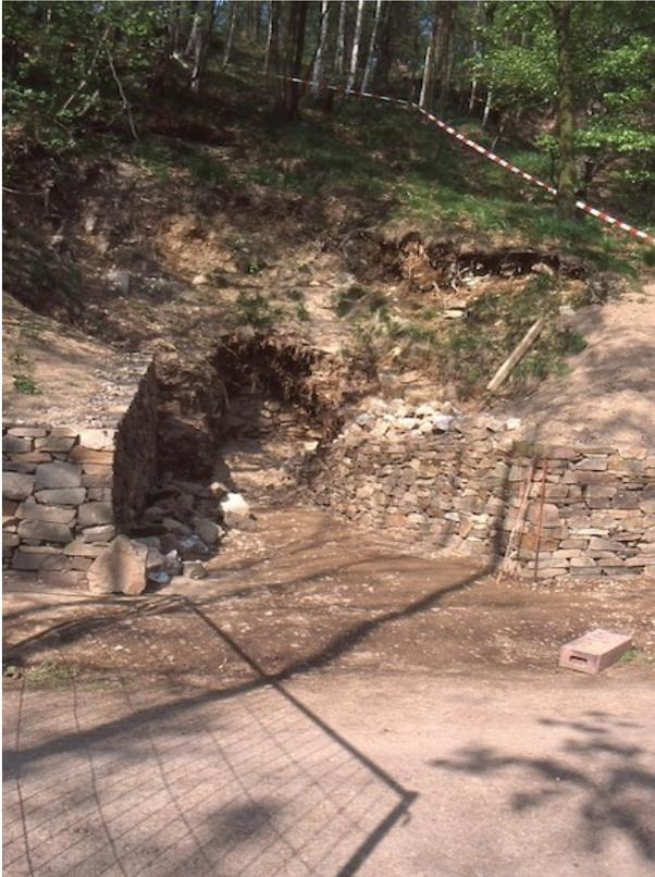
*Bild 10: teilweise geöffnete Verwahrungsmauer des Mundlochs. Der Stolln dahinter ist größtenteils bis unter die Firste verfüllt.*
