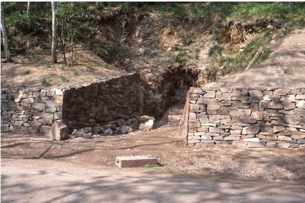
*Bild 9: Mundloch des Pegmatitstolln während der Aufwältigung. Das Material für die Trockenmauern stammt fast ausschließlich aus dem Granulitsteinbruch Seifersbach/Mittweida.*
