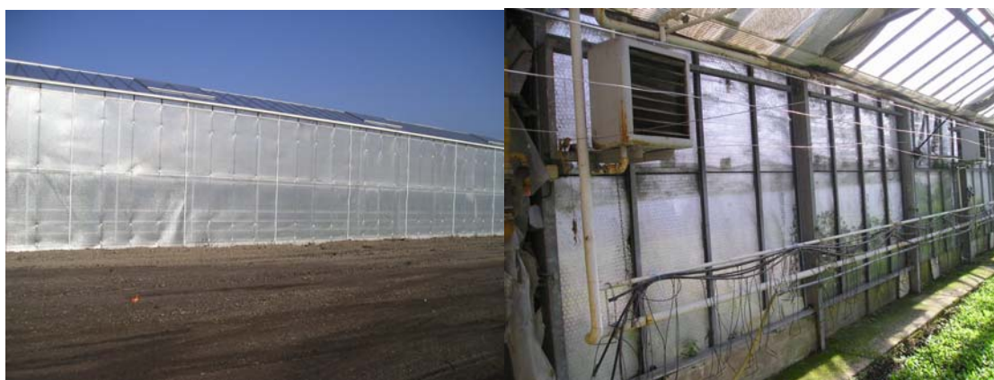
Abbildung 46: Anwendung von Noppenfolien auf Stehwänden 105
