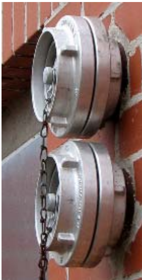
Abbildung 52: Anschluss zum Einblasen von Holzpellets in den Lagerraum 160
