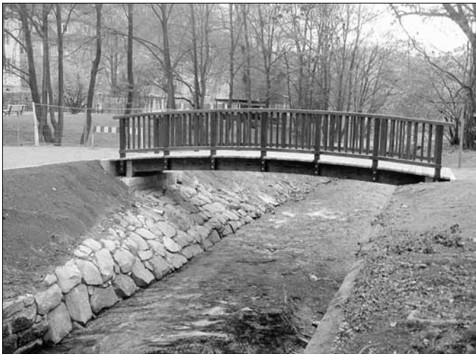
Neu errichtete Brücke im Stadtpark
