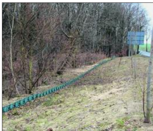
Amphibienschutzanlage an der S 255 in Remse
