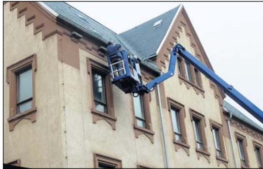
Anbringen von Nisthilfen für Mauersegler am Herrenhaus in Thurm Foto: Jens Hering
