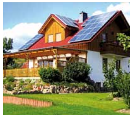
Solaranlage der Kirchner Solar Group auf einem Hausdach mit 7,38 kWp Leistung
