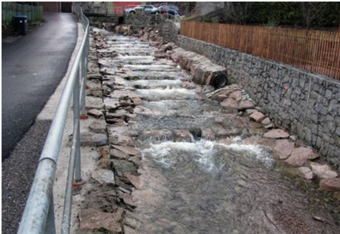
Daher wurde es im Jahr 2012 zu einer ökologisch durchgängigen Rampe umgebaut. Fische wie die Bachforelle können diese Stelle nun passieren, ein Trittstein für die Wiederbesiedlung der Schlema.
