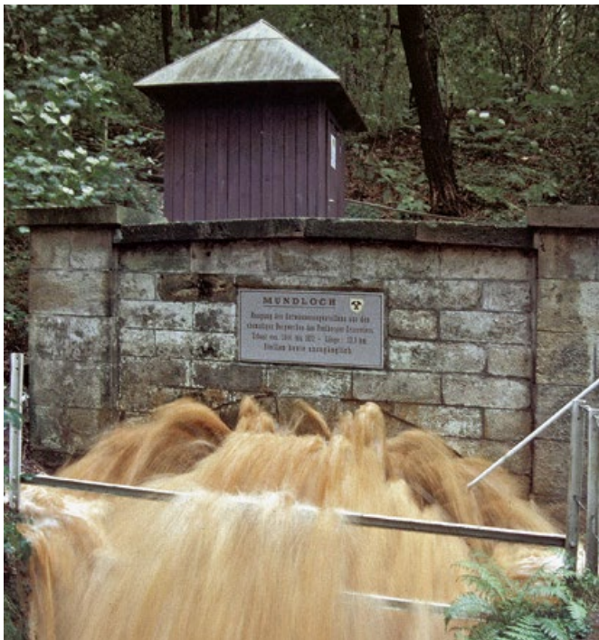
Mundloch des »Rothschönberger Stollns« beim Hochwasser 2002: Der unterirdische Stollen führt über eine Strecke von mehr als 50 Kilometern das Grubenwasser aus dem Freiburger Revier in die Triebisch ab.
