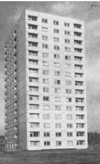
Wohnheim für ausländische Vertragsarbeitskräfte in Dresden (Blasewitzer Straße/ Fetscherstraße)
