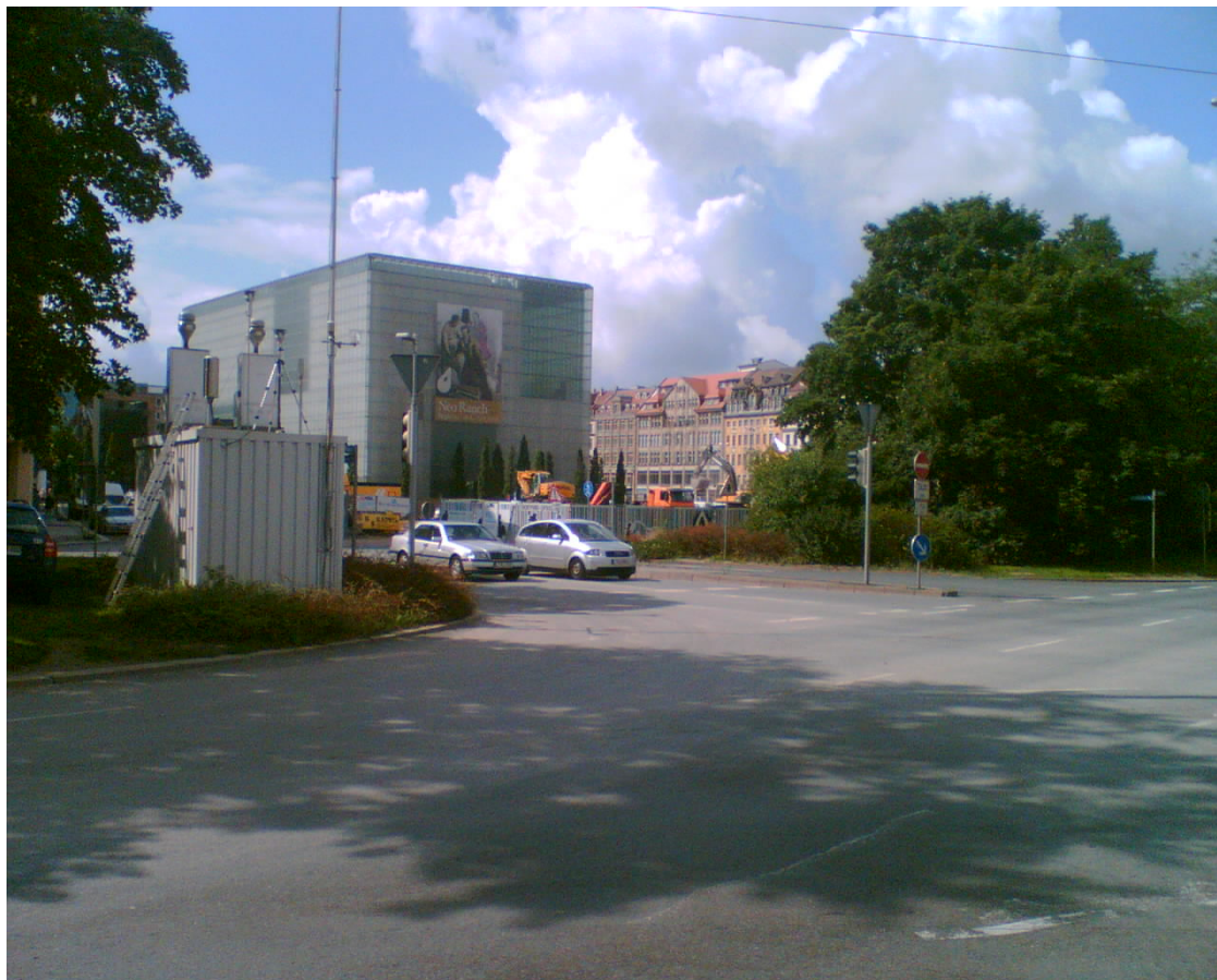
Abbildung 36: Blick auf die Einmündung der Straße „Am Hallischen Tor“, Messcontainer links
