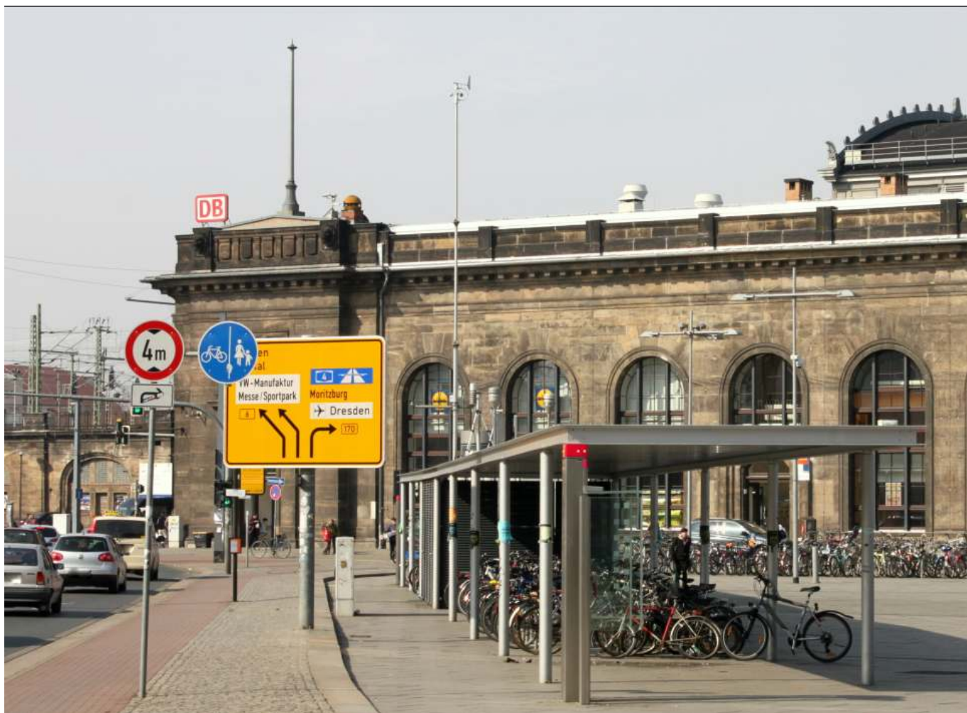
Abbildung 37: Blick von der Antonstraße auf den Schlesischen Platz, Messcontainer in der Mitte links hinter den Fahrradständern
