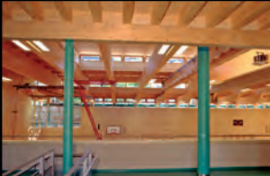
Sporthalle Görlitzer Straße, Dresden
