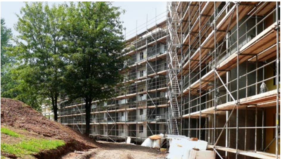
Sanierung eines Quartiergebäudes Foto: Elke und Reimund Francke
