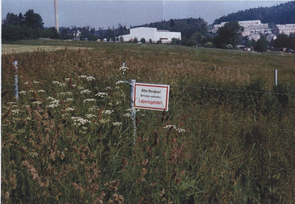
Abb. 105: Bergschadengebiet Schurf 1/66. Foto: HÖSEL
