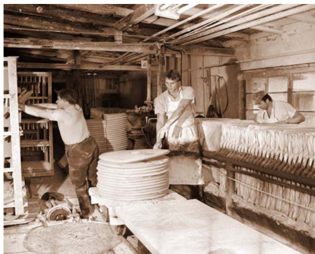
Abb. 70: Die Filterpressen wurden bis in die 1970er Jahre von Hand entleert, die zerschnittenen Filterkuchen in Trockenhunte eingestapelt.
