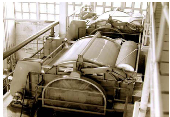
Abb. 72: Vakuumdrehzellenfilter im Werk II
