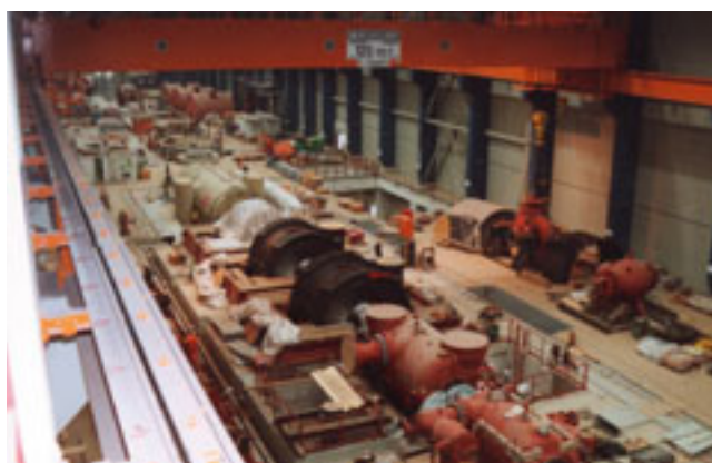
Abb. 5-4-10: Maschinenhalle des Kraftwerkes Lippendorf (alt) (Foto: R. BERGER)
