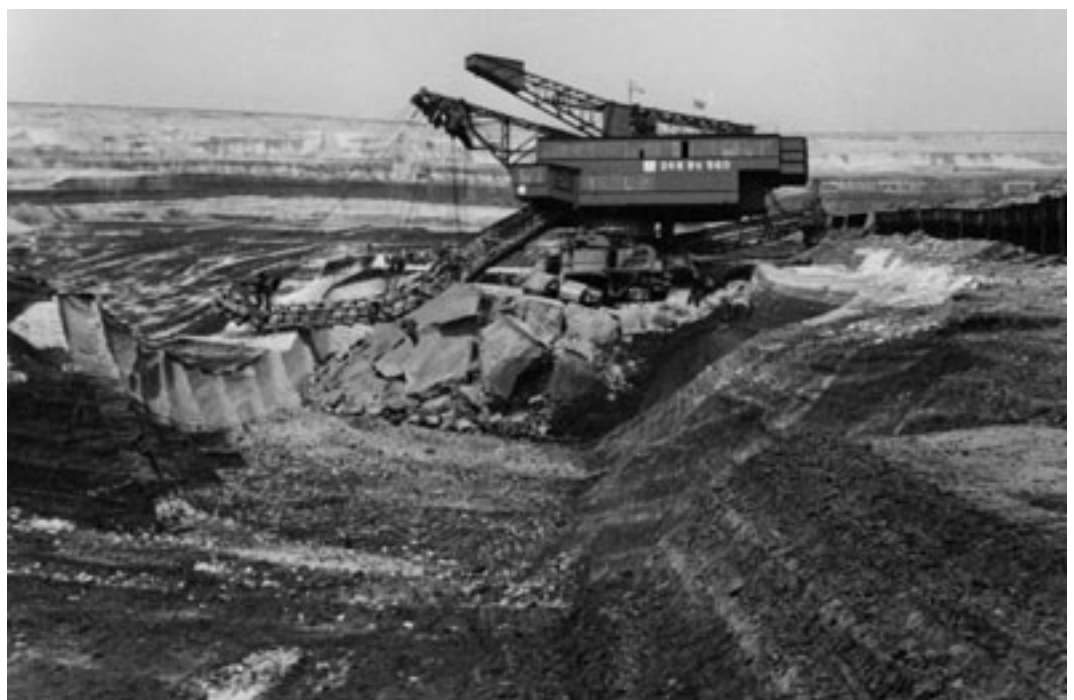
Abb. 7-8-3: Rutschung mit Geräteschaden am Bagger 269 Ers 560 Tagebau Schleenhain vom 09.07.1973 (Foto: Archiv Bergamt Borna)
