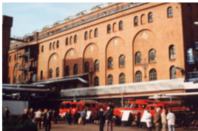
Abb. 6-1-2: Brikettfabrik Phoenix zum 90. Betriebsjubiläum 1996 (Foto: BERKNER)
