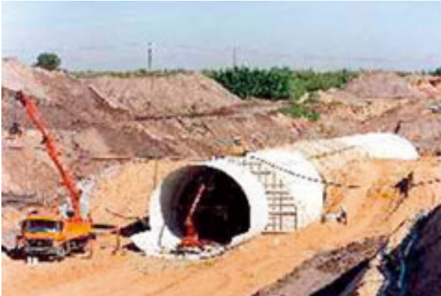
Abb. 6-2-8-2: Tunnelbau für das Kohlefernband unter der B 176 (1998) (Foto: Archiv MIBRAG mbH)
