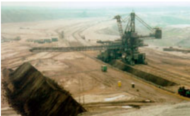
Abb. 5-2-58 : Dammaufschüttung im künftigen Hainer See mittels Zugabsetzer 1000 A 2 s 2240 im Tagebau Witznitz
