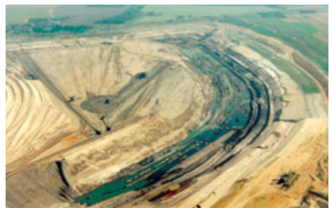
Abb. 5-2-55 : AFB-Kippenrückgewinnung Tagebau Espenhain
