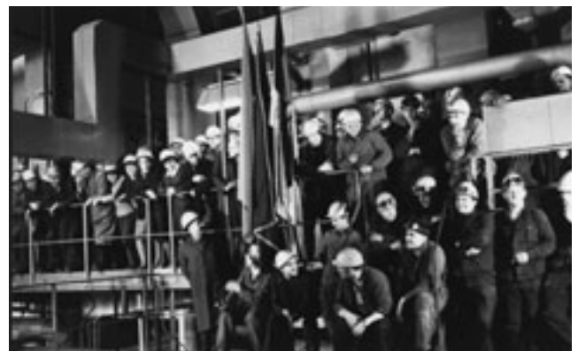
Abb. 5-4-3: Kraftwerk Borna – Inbetriebnahme nach erfolgter Rekonstruktion
