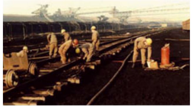
Abb. 5-2-21: Gleisarbeiter im Bereich Kippenstütze AFB 18 (1986) (Foto: Archiv LMBV mbH)
