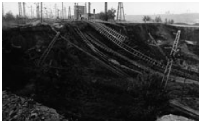
Abb. 7-8-5: Rutschung im Bereich Stellwerk 101 Tagebau Zwenkau vom 03.08.1978 (Foto: Archiv Bergamt Borna)
