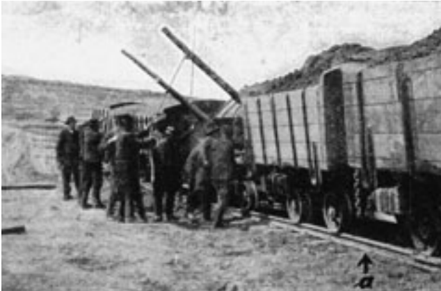
Abb. 4-5-6: Abraumzug mit einfachen Abraumwagen auf der Kippe „Kraft I“ bei Thräna 1912 (Foto: Archiv BRÄUTIGAM)
