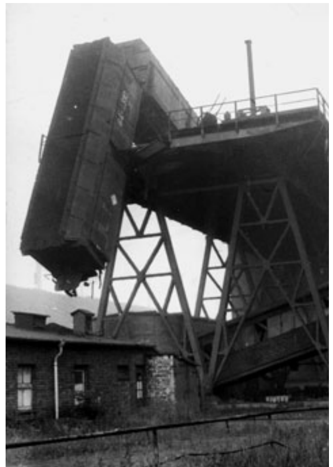
Abb. 7-8-11: Zughavarie im Bereich Bunker Brikettfabrik II Espenhain vom 02.06.1979 (Foto: Archiv Bergamt Borna)
