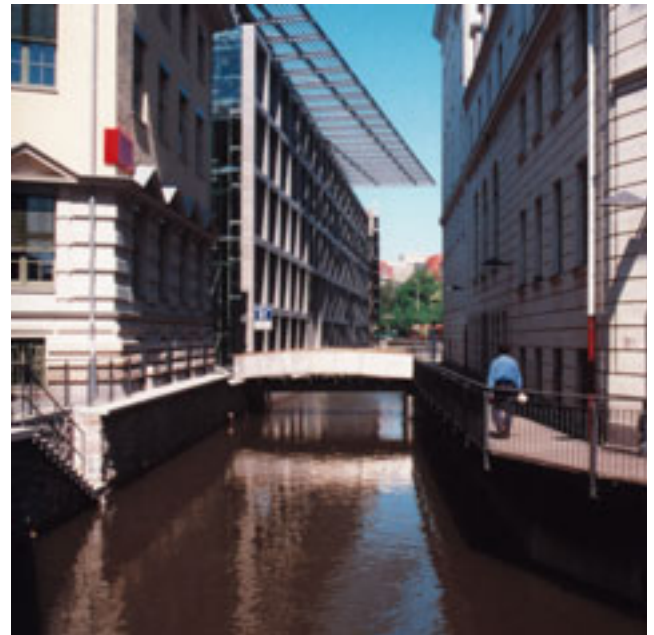
Abb. 3-3-16: Geöffneter Pleißemühlgraben in Leipzig, Bereich Otto-Schill-Straße 2002 (Foto: BERKNER)
