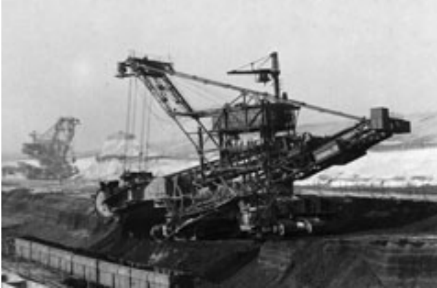
Abb. 4-9-4: Bagger 128 im Großtagebau Schleenhain (Foto: Archiv BRÄUTIGAM)
