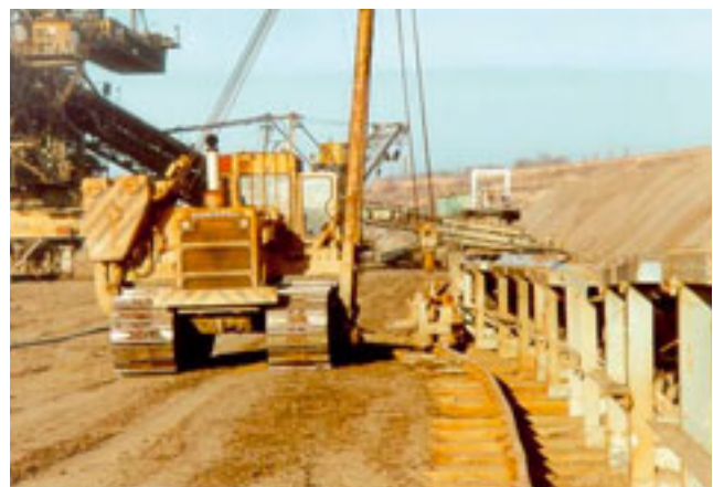
Abb. 5-2-50: Rückarbeiten an der Bandanlage Espenhain
