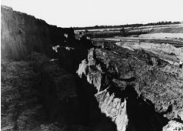
Abb. 2-3-7: Tagebau Zwenkau, Brückentiefschnitt, Rutschung auf VG Bänderschluft
