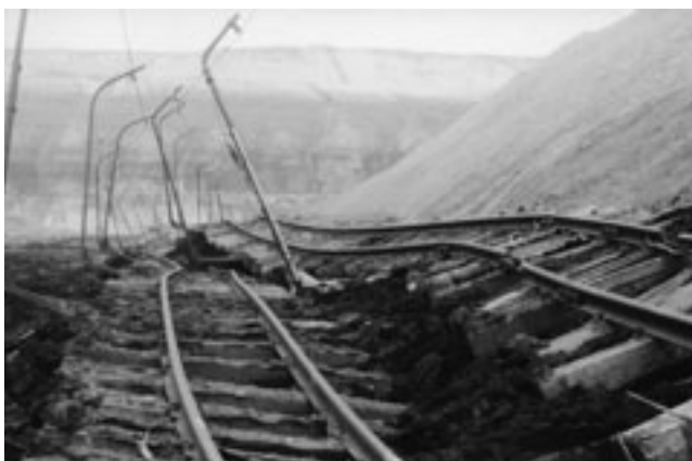
Abb. 2-3-3: Tagebau Zwenkau, Bruch der Stützkippe am Strossenende mit Gleisverwerfungen im Unterflöztiefschnitt vom 08.04.1984
