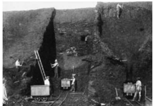
Abb. 4-5-3: Kohlegewinnung von Hand im Schlitzschurrenbetrieb (Foto: Archiv BRÄUTIGAM)
