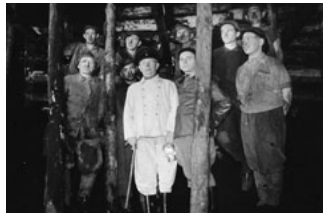
Abb. 4-9-2: Bergleute im Schacht „Nothilfe“ unter Tage (Foto: Archiv BRÄUTIGAM)
