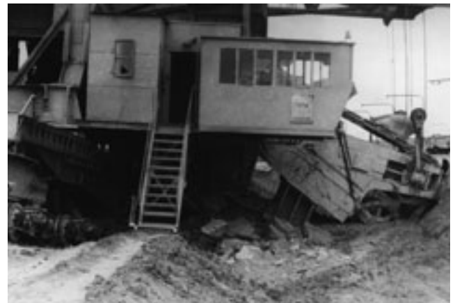
Abb. 2-3-9: Böschungsgrundbruch am Absetzer 1007 im Tagebau Bockwitz am 19.07.1986
