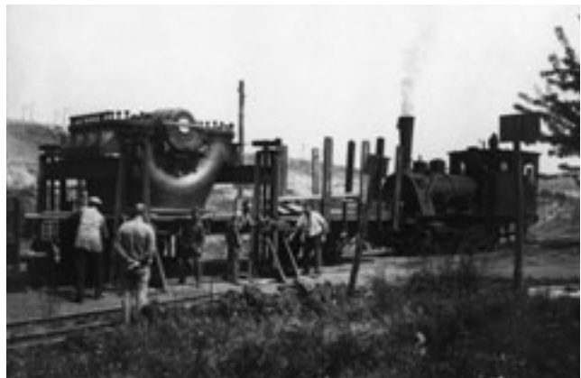
Abb. 5-4-5: Ausrüstungstransport beim Bau des Kraftwerkes Böhlen
