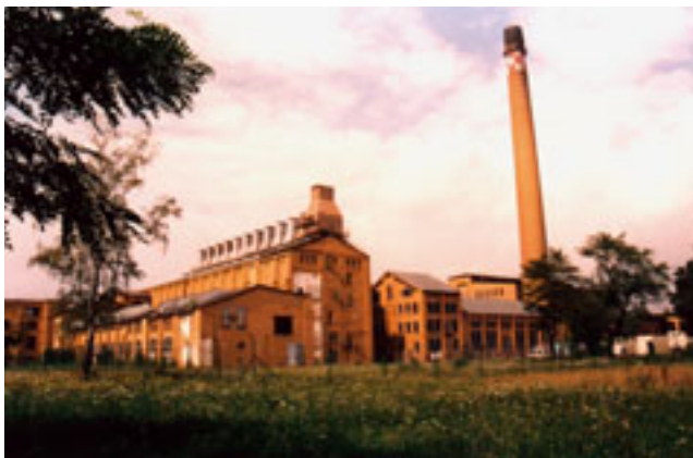
Abb. 6-2-6-2: Brikettfabrik Witznitz (Gesamtansicht von Osten) (Foto: MESCHKE)
