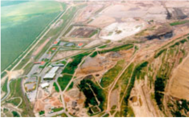
Abb. 5-2-62: Zentraldeponie Cröbern Innenkippe Tagebau Espenhain
