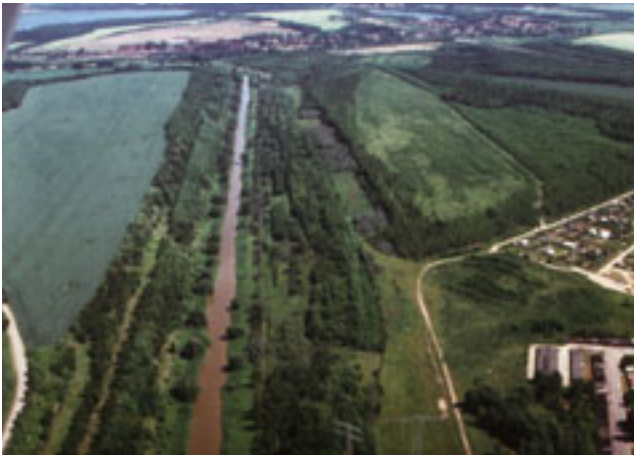
Abb. 3-3-4: Die Pleiße-Verlegung bei Neukieritzsch (Foto: BERKNER)
