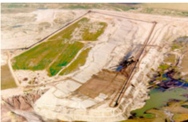
Abb. 5-2-52 : Stützdammerschüttung Innenkippe Peres
