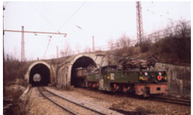
Abb. 5-6-13: Kreuzungsbauwerk Tagebau Zwenkau 1996 (Foto: NEDDERMEIER)
