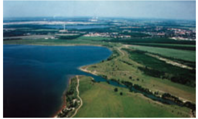
Abb. 3-3-11: Speicher Borna – Gesamtansicht 1996 (Foto: BERKNER)
