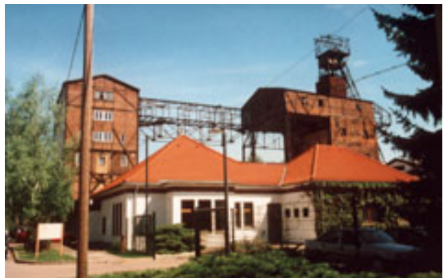
Abb. 6-2-1-1 : Förderschacht Dölitz (Gesamtansicht) (Foto: BERKNER)
