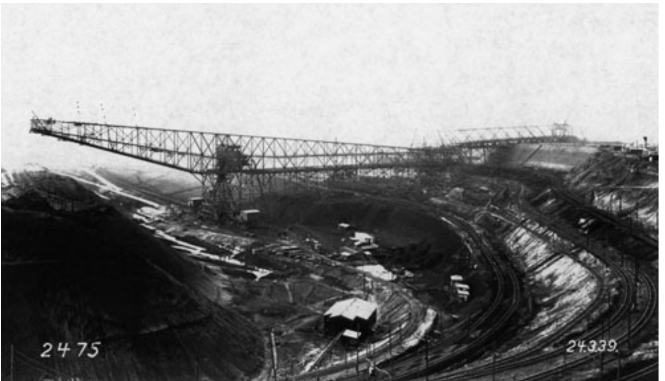
Abb. 1-3: Abraumförderbrücke Böhlen II in der Endphase der Montage 1939
