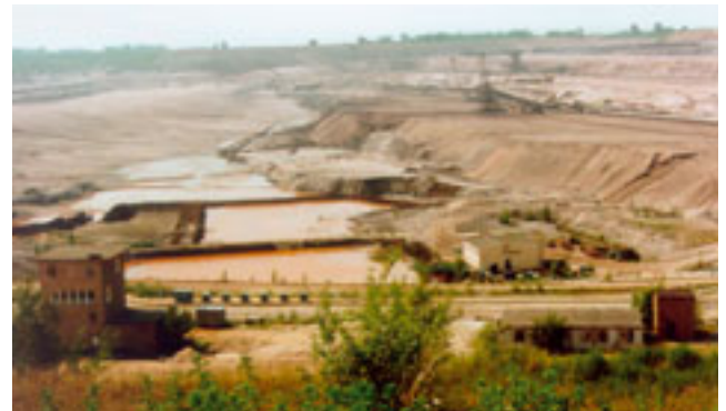
Abb. 5-2-53 : Anstützung der setzungsfließgefährdeten Innenkippe im Tagebau Grotzschers Dreieck
