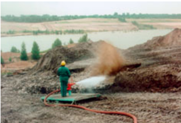
Abb. 5-2-51 : Böschungregulierung durch Abspülen im Südostbereich Tagebau Cospuden
