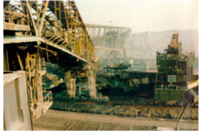
Abb. 5-2-31: AFB 17 Blick auf Zwischen- und Hauptbrücke in Kurzschüttung
