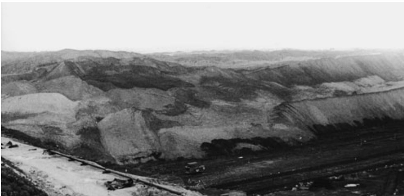
Abb. 2-3-2: Tagebau Zwenkau, Bruch der Stützkippe am Strossenende infolge Massenzusammendrängung auf der Hauptkippe am 29.06.1983
