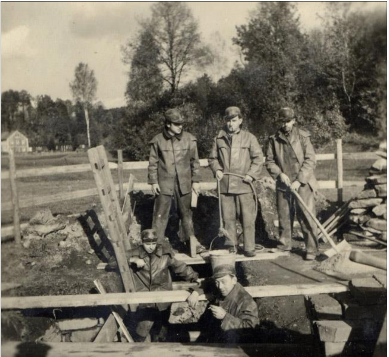
Während der Sanierung des „Weiße Rose Schachtes“ im Rahmen des „18-Punkte-Hochwasserschutzprogrammes“ von 1955. Foto: R. Klanthe
