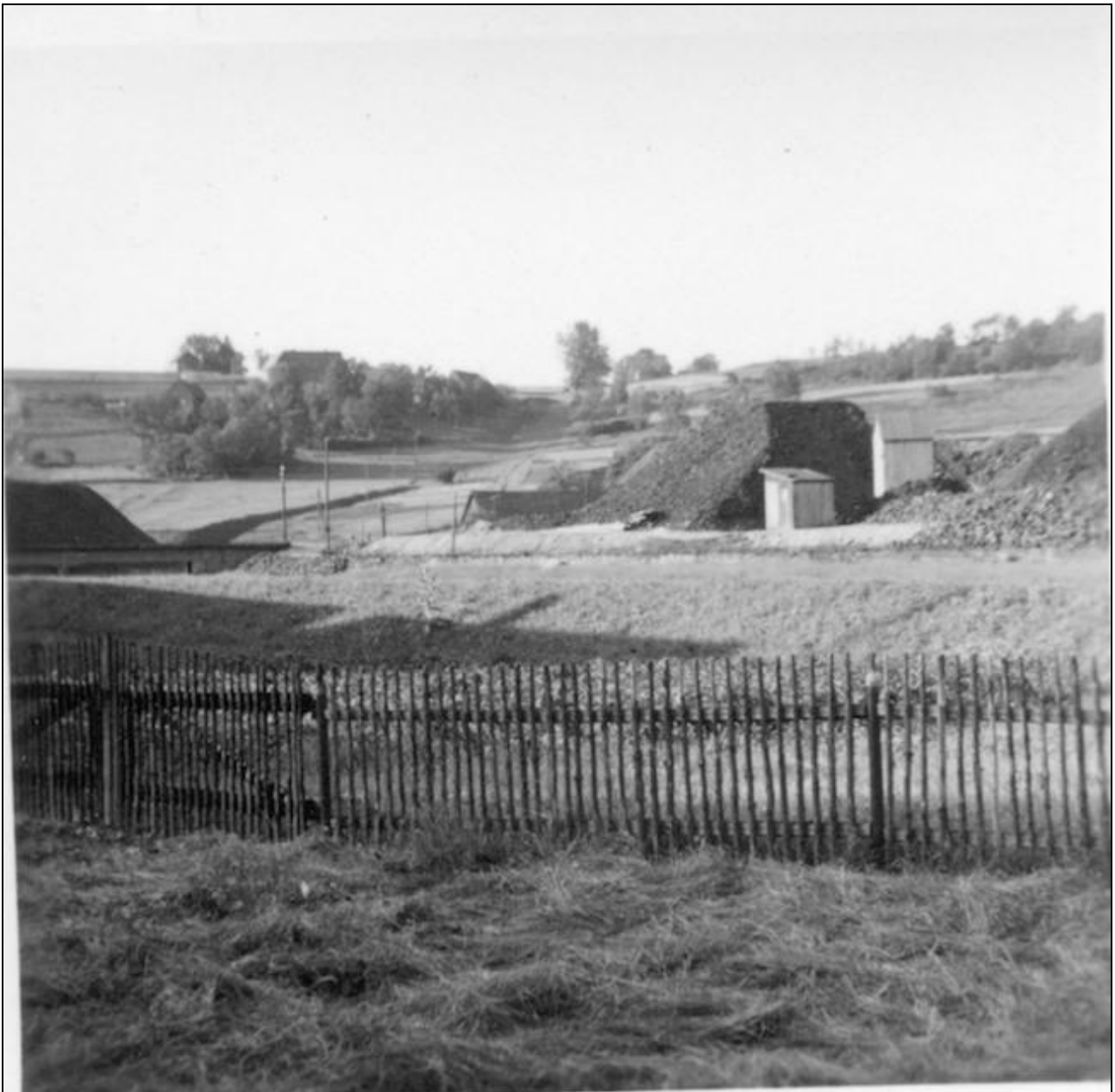
Ansicht der Grube „Neue weiße Rose“ vom Grundstück Freiberger Weg 1 aus. Aufgrund des Hochwassers von 1954 erfolgte eine Sanierung dieses Schachtes und der Grubenbaue. Foto: Jürgen Lange (†)
