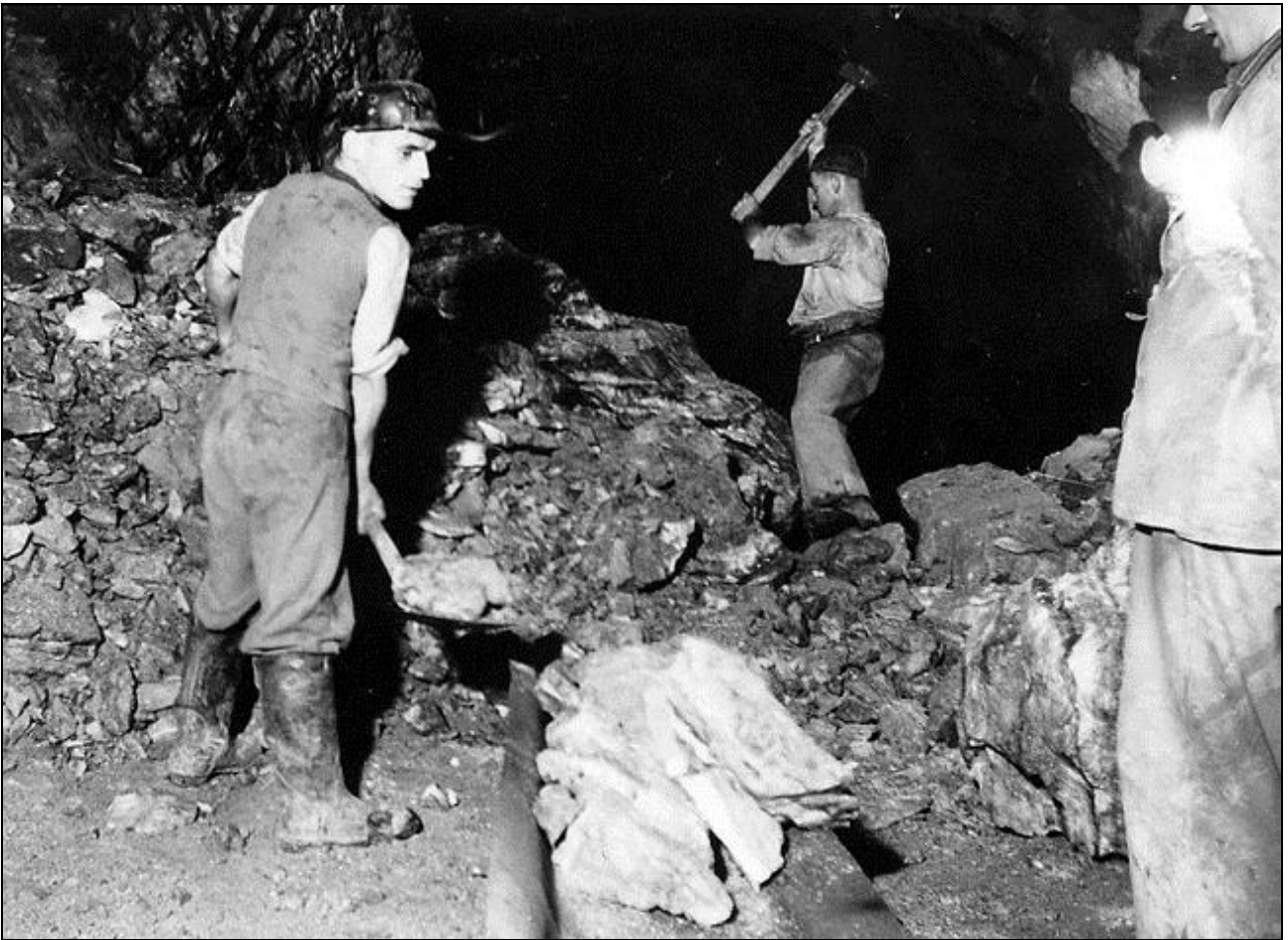
Wegfüllarbeit im Abbau 3 auf der 200 m Sohle um 1940. Digitalisat: Sammlung H. Herklotz
