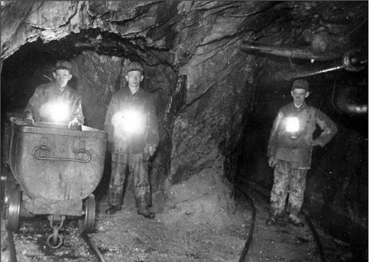
50 m Sohle mit Gangauffahrung im Ostfeld. Links das harte Trum und rechts das weiche Trum des Halsbrücker Spates. Digitalisat: Sammlung H. Herklotz
