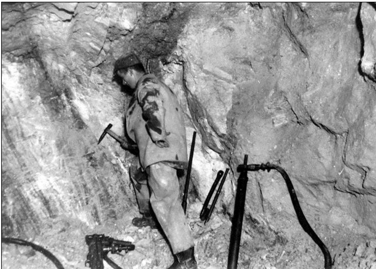
Streckenvortrieb auf der 250 m Sohle mit Flottmann-Bohrhammer und Bohrstütze. Digitalisat: Sammlung H. Herklotz
