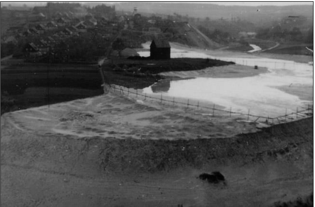
Zwei Ansichten der Spülsandhalde im Muldental. Oben der Zustand um 1955 und im Bild unten gegen Ende der 1950er Jahre. Hier wird die Halde vom 7. Lichtloch umspült und auch der „Churprinzer Kanal“ verschwindet unter den Sandmassen. Foto: Herrmann, Digitalisat: Sammlung H. Herklotz
