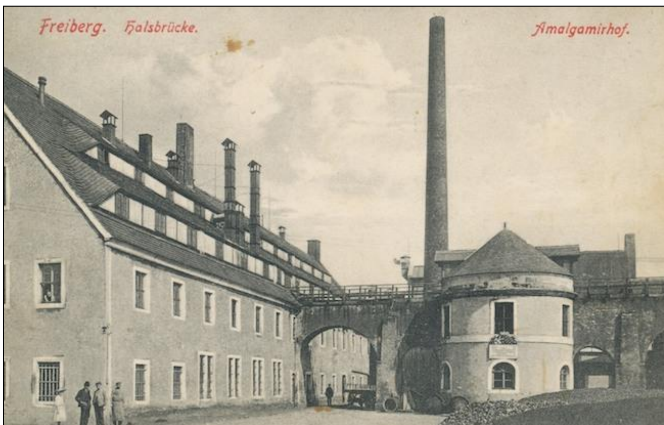
Ansicht des Druckwerkes auf dem Hüttenhof auf einer zeitgenössischen Postkarte. Sammlung N. Bonk.
