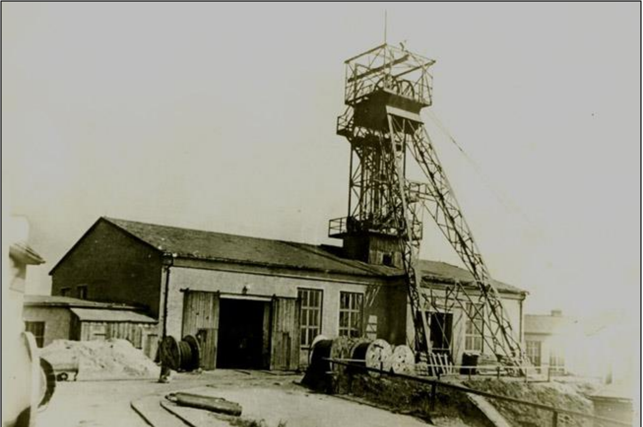
Ansicht des Schachthauses mit dem neuen Fördergerüst von 1955. Digitalisat: Sammlung H. Herklotz
