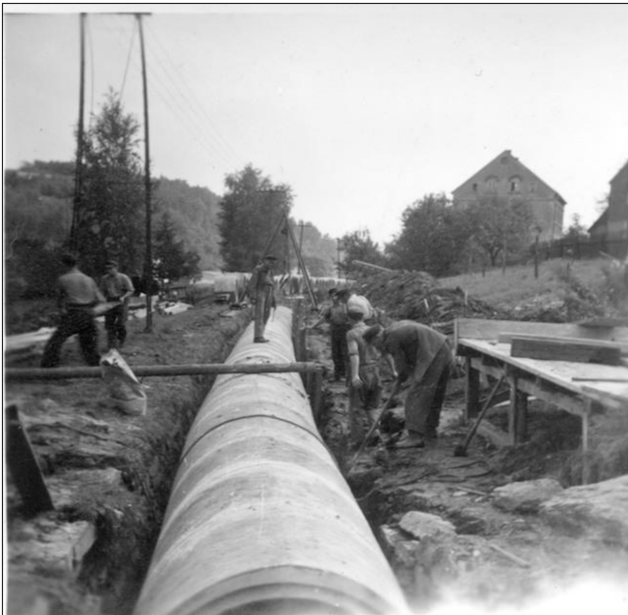
Im Rahmen des „18-Punkte-Hochwasserschutzprogrammes“ der Grube „Beihilfe“ erfolgte als Hochwasserschutz auch die Verrohrung des Hüttengrabens. Im Bild der Abschnitt auf Höhe Grundstück Freiberger Weg 1. Foto: Jürgen Lange (†)
