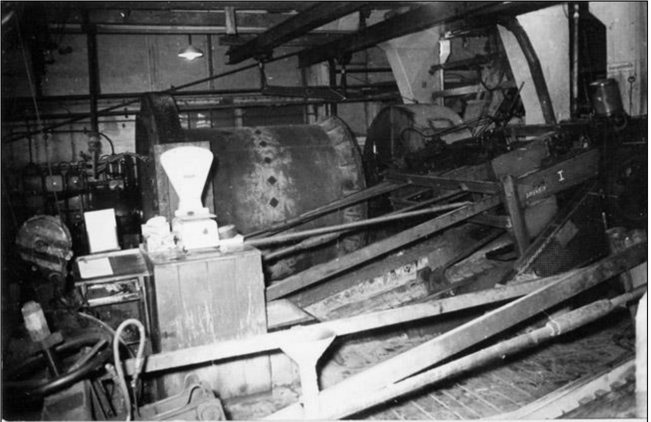
Ansichten der Kugelmühle in der Aufbereitung. Hier wurde das Erz zerkleinert. Digitalisat: Sammlung H. Herklotz
