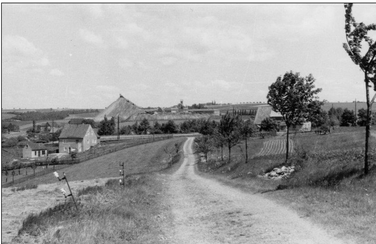
Zwei Ansichten der wohl markantesten Schachthanlage des Halsbrücker Bergbaus: Der Ferdinandschacht in Rotenfurth. Digitalisat: Sammlung H. Herklotz
