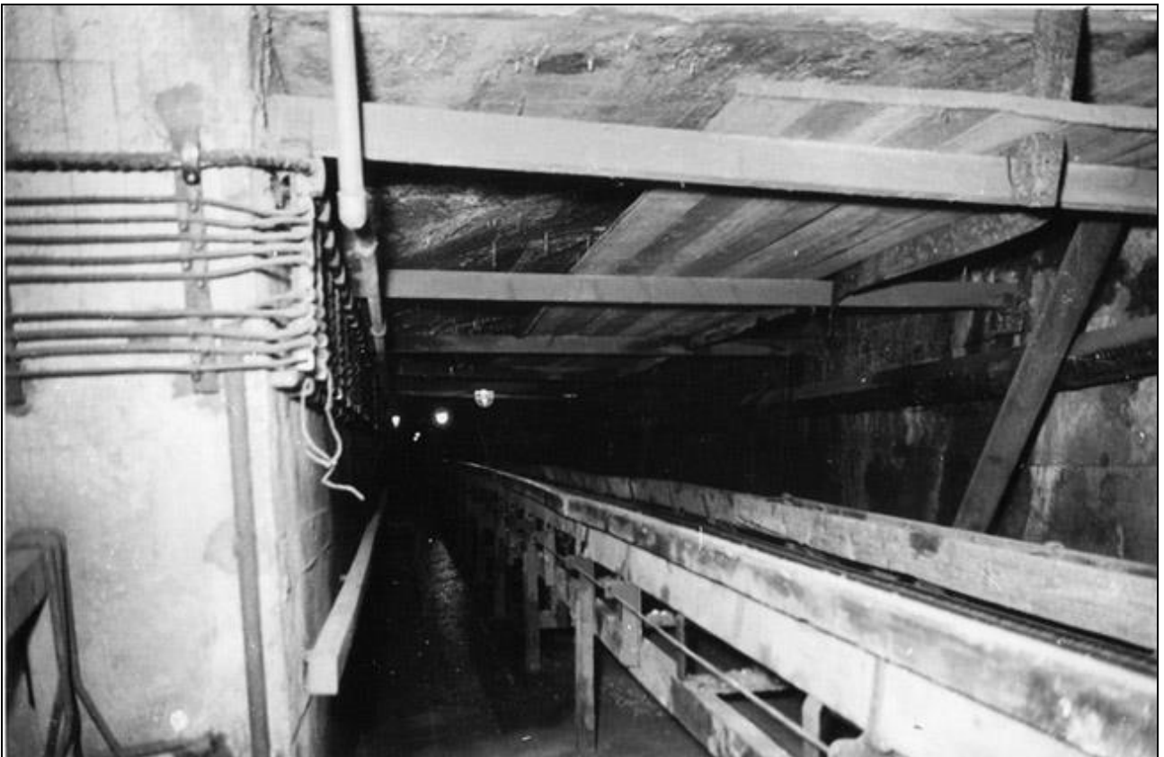
Ein Blick in den Schrägschacht mit der Förderbandanlage zwischen Aufbereitung und dem Hauptschacht. Digitalisat: Sammlung H. Herklotz
