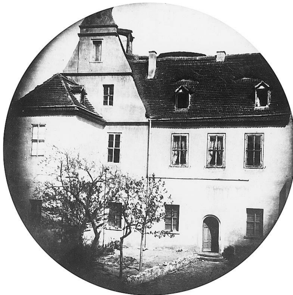
Abbildung 5.10 Altes Physikalisches Institut, Jägergasse 2 vor dem Umbau (Hinteransicht)
