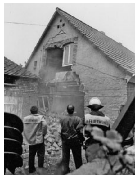
Abb. 21: Gebirgsschlag Teutschenthal vom 11. September 1996, Teileinsturz der Außenfront eines Wohnhauses in Zscherben (Foto: G. BAUER, Mitteldeutsche Zeitung, Halle)
