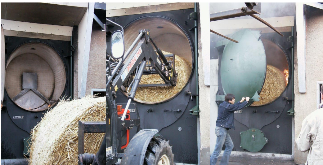
Abb. 37: Auflegen des Strohballens auf das Glutbett aus verbranntem Scheitholz
