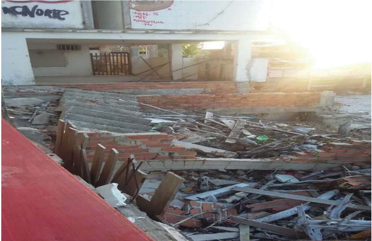
Foto 1: Erosão ocasionada pela maré
