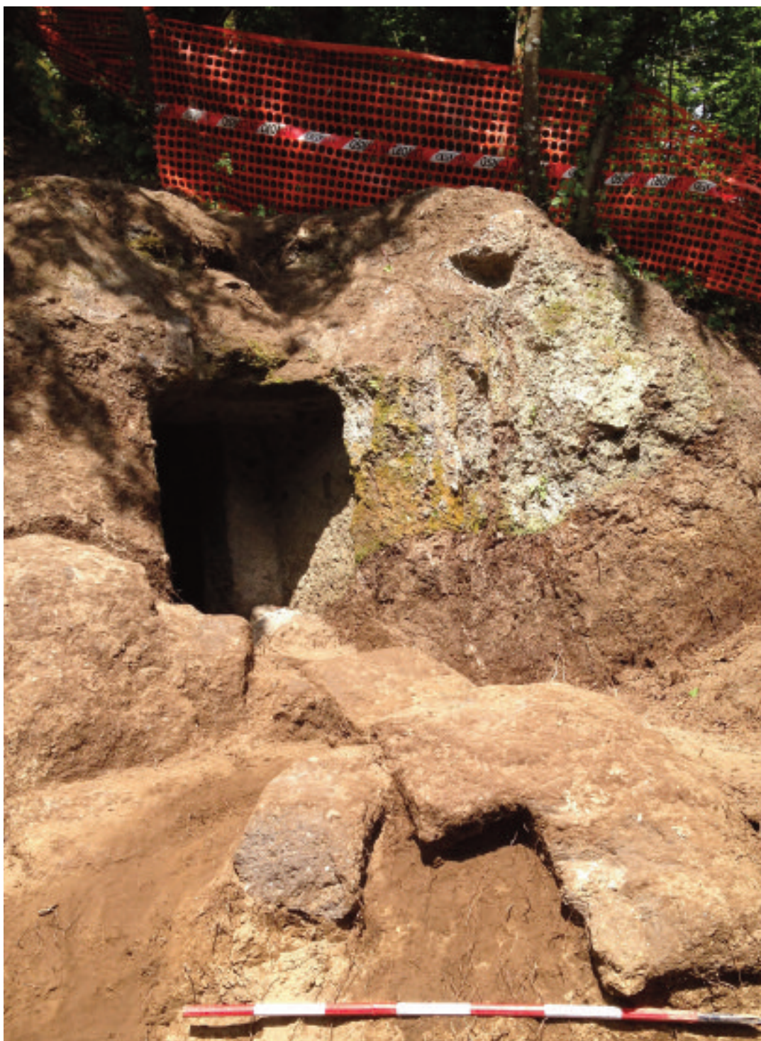
15. NARCE. NECROPOLI DEL CAVONE DI MONTE LI SANTII, PARTE DEL CROLLO DELLE FACCIATE DI FRONTE ALLA TOMBA C, DA SUDEST (foto M. Pacifici per AFSAR-LAZ)
