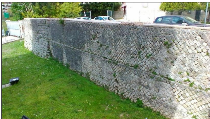
11. Tratto di mura in opera reticolata presso Porta Romana.
