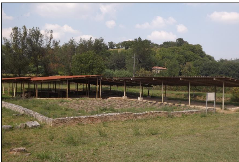
67. San Severino Marche ( Septempeda ), le terme.
