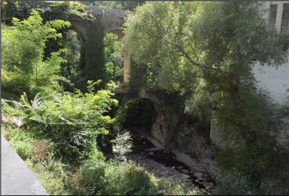
20. Acquisanta, Ponte romano sul Rio Garrafo (in basso).
