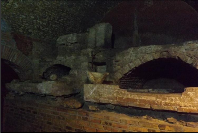
43. Le Grandi Cisterne, impianto medievale per la produzione del vino.
