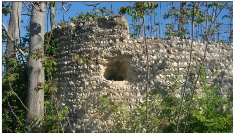
4. Monteprandone, vasca di accumulo.
