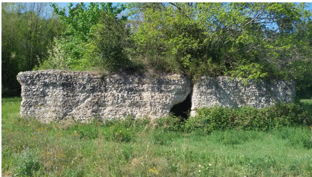
35. Campofilone, cisterna romana.
