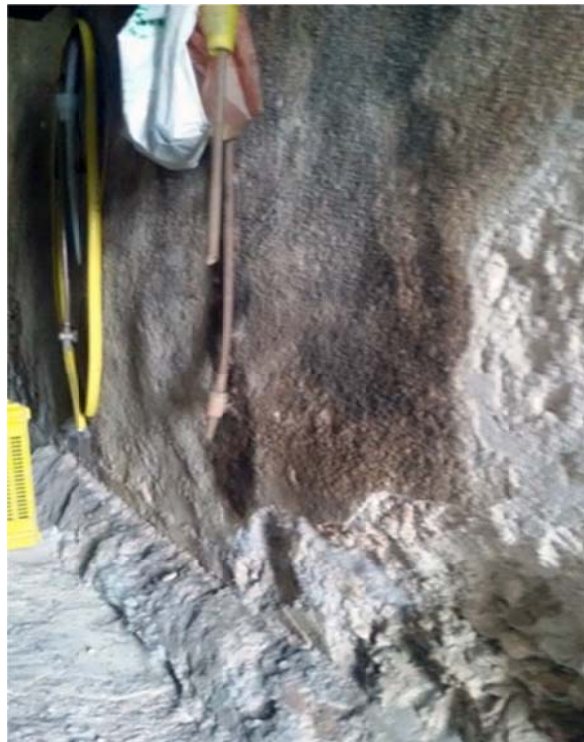
Fig. 23 - Cupra Marittima, caput aquae , camera sud, particolare del cordolo della pavimentazione in cocchiopesto idraulico
