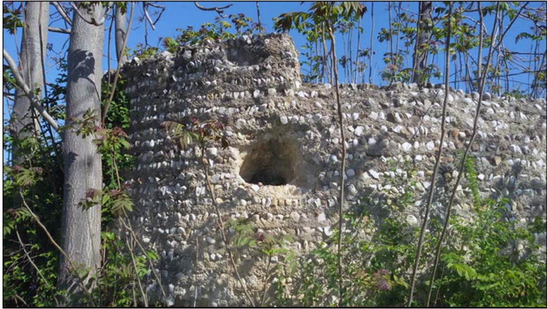
Fig. 30 - Monteprendone (Ap), Contrada S. Maria delle Grazie (42°54'28.25"N; 13°50'50.91"E), vasca circolare d'accumulo
