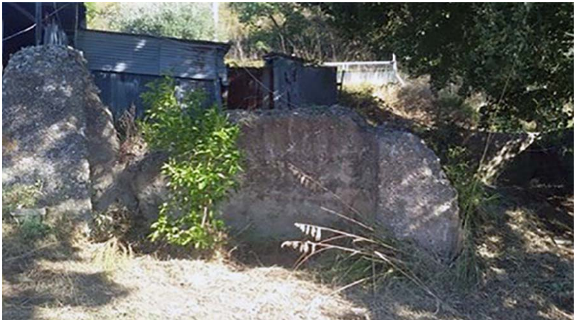
Fig. 11 - Grottammare, Contrada Sgariglia (42°57'56.63"N; 13°50'57.78"E), vasca quadrangolare d'accumulo a cielo aperto. In primo piano è visibile uno dei semipilastri di rinforzo
