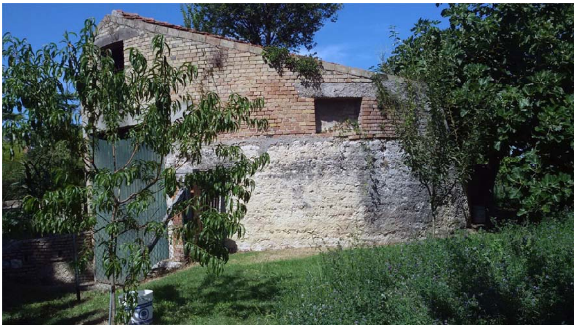
Fig. 25 - S. Omero (Te), Via dei Saraceni, Masseria Cerulli Irelli (42°47'3.30"N; 13°48'22.16"E), vasca circolare d'accumulo
