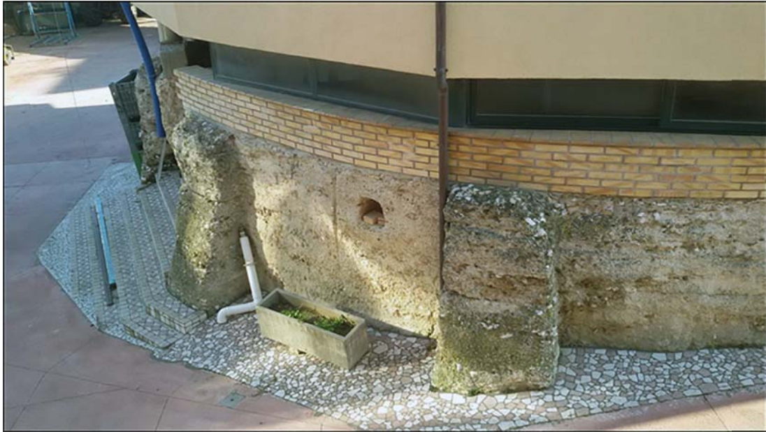
Fig. - 26 S. Omero (Te), Contrada Case Alte, Cisterna De Bartolomeis (42°47'20.53"N; 13°49'0.69"E), vasca circolare d'accumulo con semipilastrini di rinforzo sul lato fuori terra
