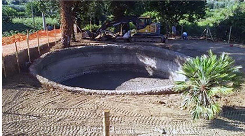
Fig. 7 - Grottammare (Ap), Bagno della Regina (42°58'58.51"N; 13°51'0.68"E), vasca circolare d'accumulo; stato del manufatto dopo lo svuotamento
