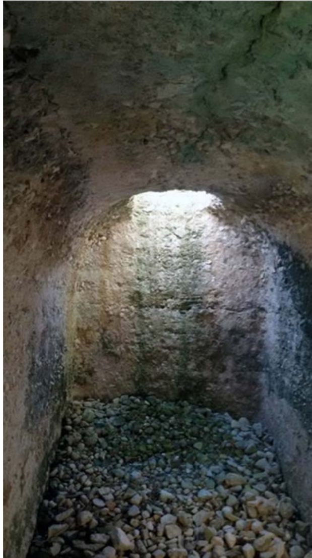
Fig. 18 - Campofilone, cisterna a doppia camera, interno della camera nord
