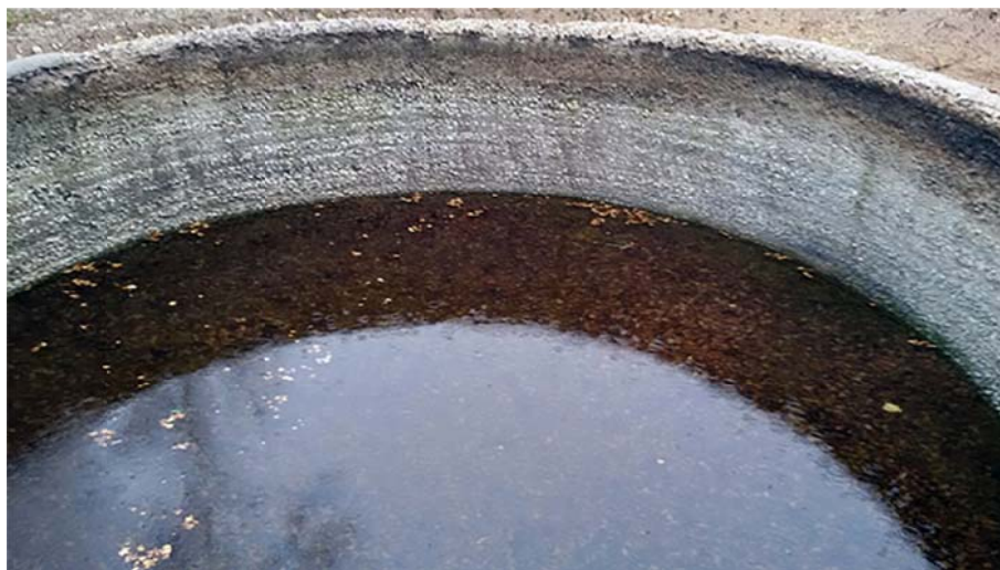
Fig. 9 - Grottammare, Bagno della Regina, interno della vasca con visibili le tracce delle "giornate" di lavoro
