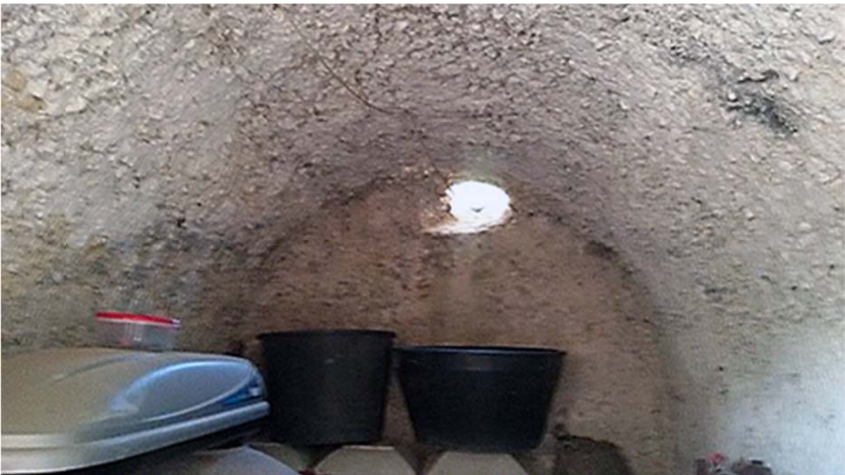
Fig. 21 - San Benedetto del Tronto (Ap), cisterna a doppia camera, interno
