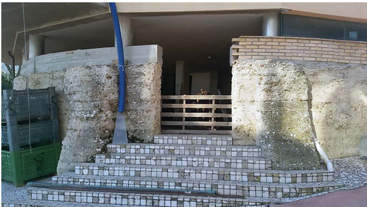
Fig. 35 - S. Omero, la cisterna De Bartolomeis riutilizzata come basamento per una villa moderna (foto 2017)
