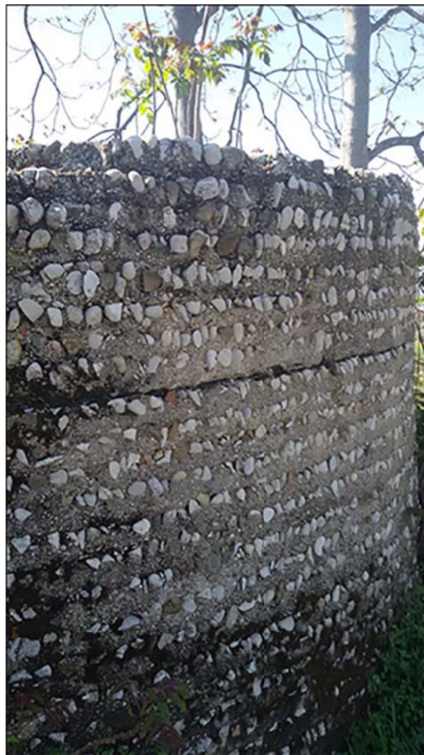
Fig. 31 - Monteprendone, vasca d'accumulo: particolare delle "giornate" di lavoro riconoscibili sulla faccia esterna del serbatoio
