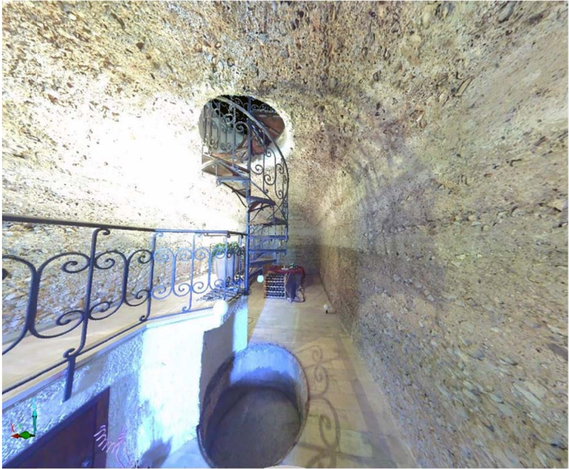
Fig. 10 - Grottammare, Casale Romani (42°58'17.60"N; 13°51'9.71"E), cisterna a camera singola
