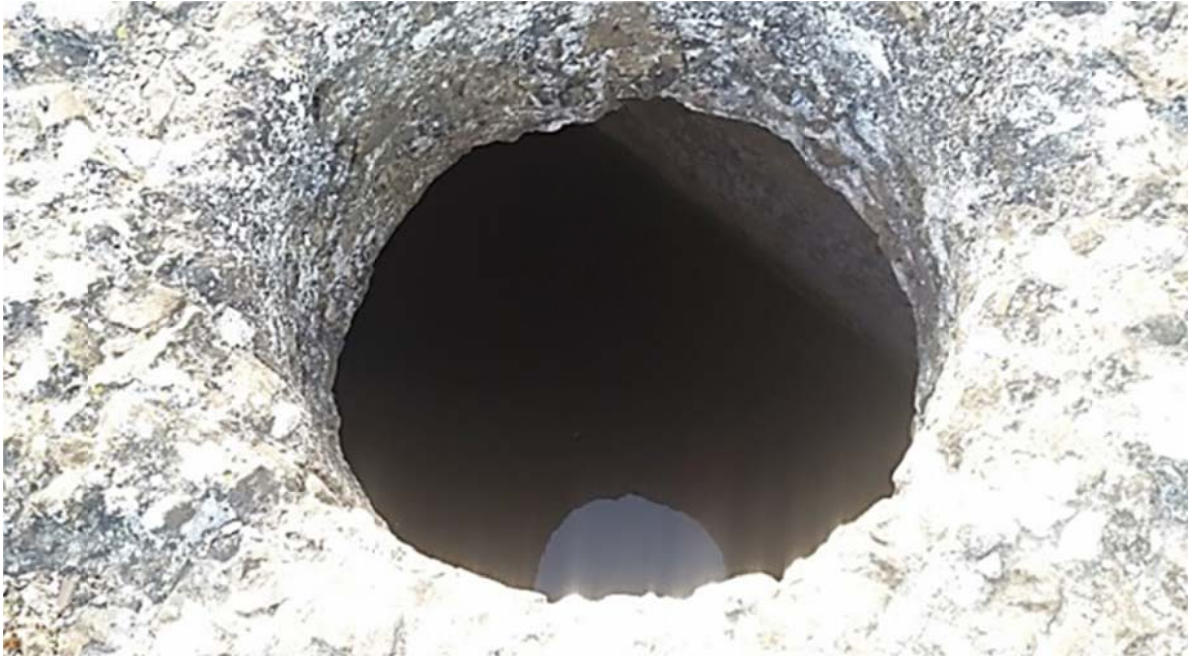
Fig. 16 - Colonnella, cisterna a doppia camera, particolare dell'imboccatura
