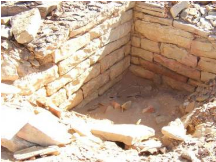
Fig. 35 - particolare della tecnica muraria con messa in opera a secco e inzeppature dove necessario (Foto R. Valentini)
