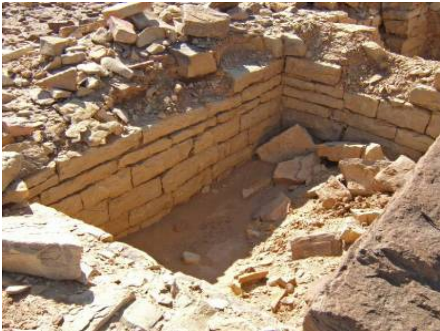
Fig. 34 - Particolarità della tecnica muraria ad opera pseudo-isodoma (Foto R. Valentini)
