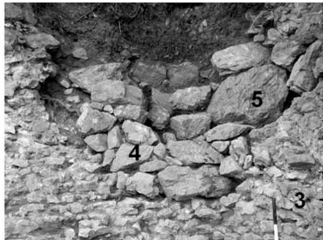
Fig. 15 – Aveia , «città alta», angolo fra i tratti 1 e 2 della fortificazione. Dietro al nucleo in cementizio è stata individuata una più antica sostruzione in opera poligonale (3. nucleo in cementizio; 4. sostruzione a secco d'età moderna; 5. sostruzione in poligonale).
