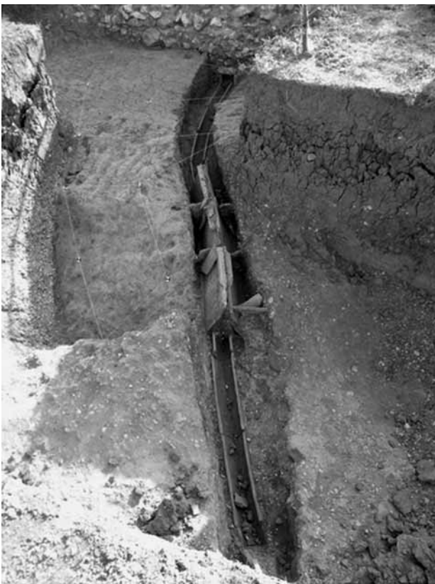
Fig. 12 – Aveia , tratto 5 della fortificazione, saggio 1: il paramento interno e la canaletta di drenaggio.
