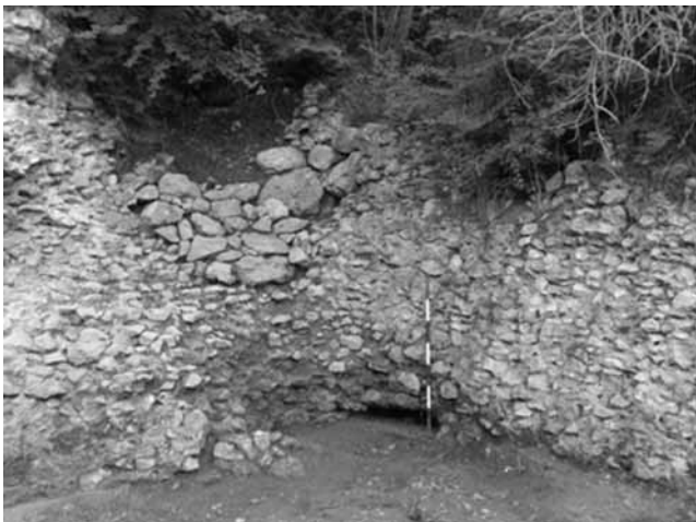
Fig. 15 – Aveia , «città alta», angolo fra i tratti 1 e 2 della fortificazione. Dietro al nucleo in cementizio è stata individuata una più antica sostruzione in opera poligonale (3. nucleo in cementizio; 4. sostruzione a secco d'età moderna; 5. sostruzione in poligonale).
