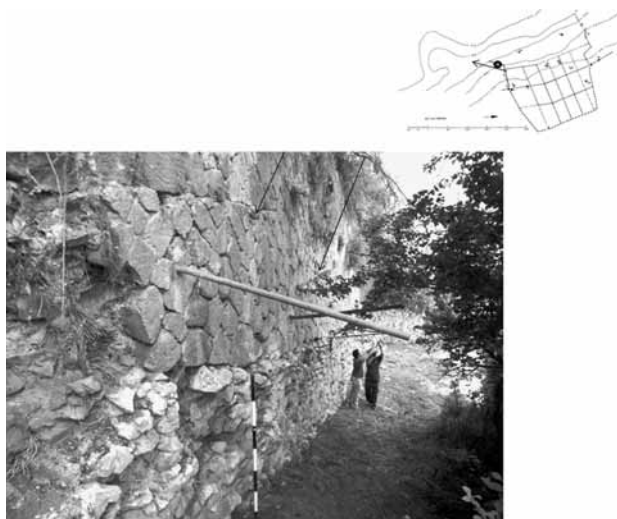
Fig. 4 – Aveia, «città alta», tratto 1 della fortificazione: il marcapiano a gradoni.
