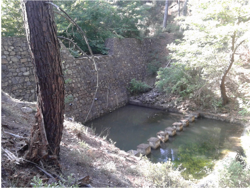
Εικόνα 4. Πέτρινο φράγμα ανάσχεσης που κατασκευάστηκε στον χειμάρρο Πανοράματος στο πλαίσιο της εφαρμογής της μελέτης Μαργαρόπουλου, κοντά στο «Κτήμα Μητρούση», πιθανότατα γύρω στο 1950 (φωτογραφία: Γ. Μπλιώνης, Ιούνιος 2017).
