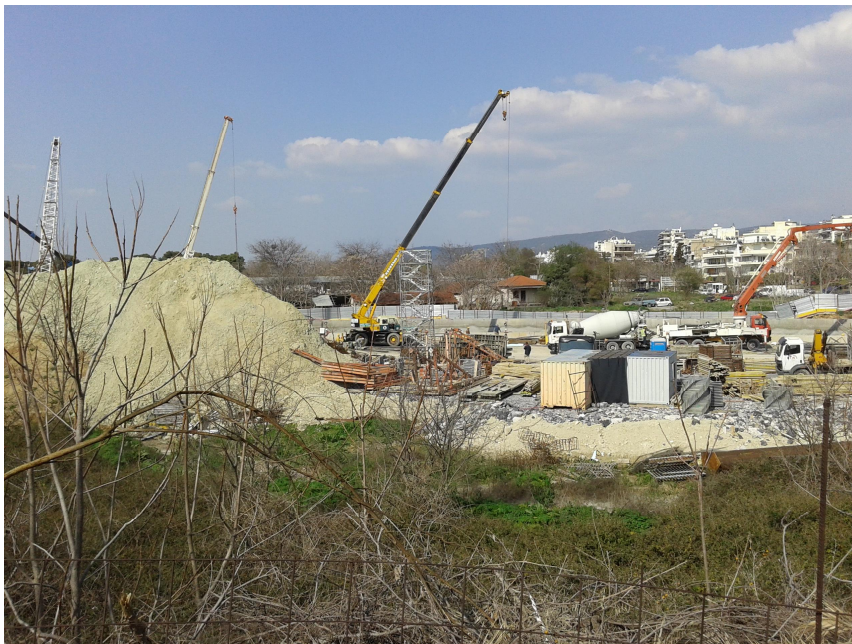
Εικόνα 8. Τεράστια χωματουργικά έργα στη Νέα Ελβετία, στην έκταση της πρώην λίμνης του χειμάρρου Αλλατίνη/Ντεπώ, για την κατασκευή του σταθμού του μετρό, δυο χρόνια μετά, από το ίδιο σημείο του ναού Αγίου Βασιλείου (φωτογραφία: Γ. Μπλιώνης, Μάρτιος 2017).
