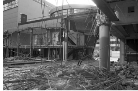
3.20 pav. Nyderlandų šokio teatras, griovimo darbai 2016 m.
