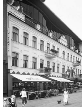
2.31 pav. Viešbučio „Kaunas“ rekonstrukcija Laisvės al., Kaune, arch. V. Juozaitis, 1999–2002 m.
