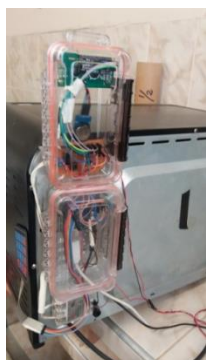
(a) Instalaciones eléctricas y electrónicas
