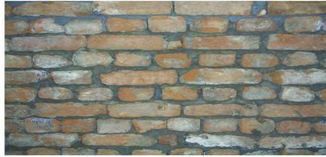
Şekil 1. Örülmüş tuğla duvarın görüntüsü
