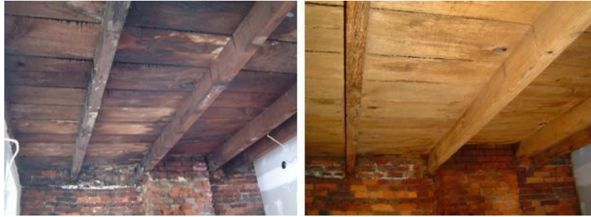
Şekil 14. Kuru buz ile yüzeyi temizlenecek ve temizlenen ahşap tavan[18]
