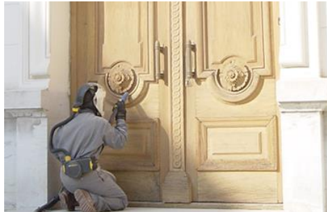
Şekil 11. Yüzeyi temizlenen kapı[15]
