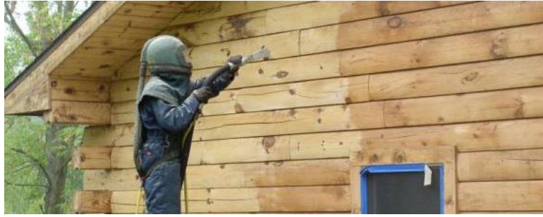
Şekil 12. Plastik medya ile temizliği yapılan ahşap yapı[15]
