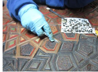
Şekil 5. Ahşap kapı restorasyonu (b)[9]
