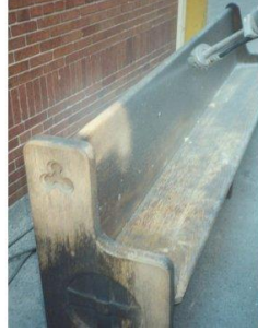
Şekil 15. Sodyum bikarbonat ile yüzey temizliği [13]
