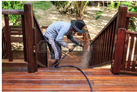
Şekil 13. Su ile yüzeyi temizlenen ahşap korkuluklar[17]
