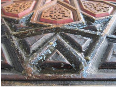
Şekil 4. Ahşap kapı restorasyonu (a)[9]
