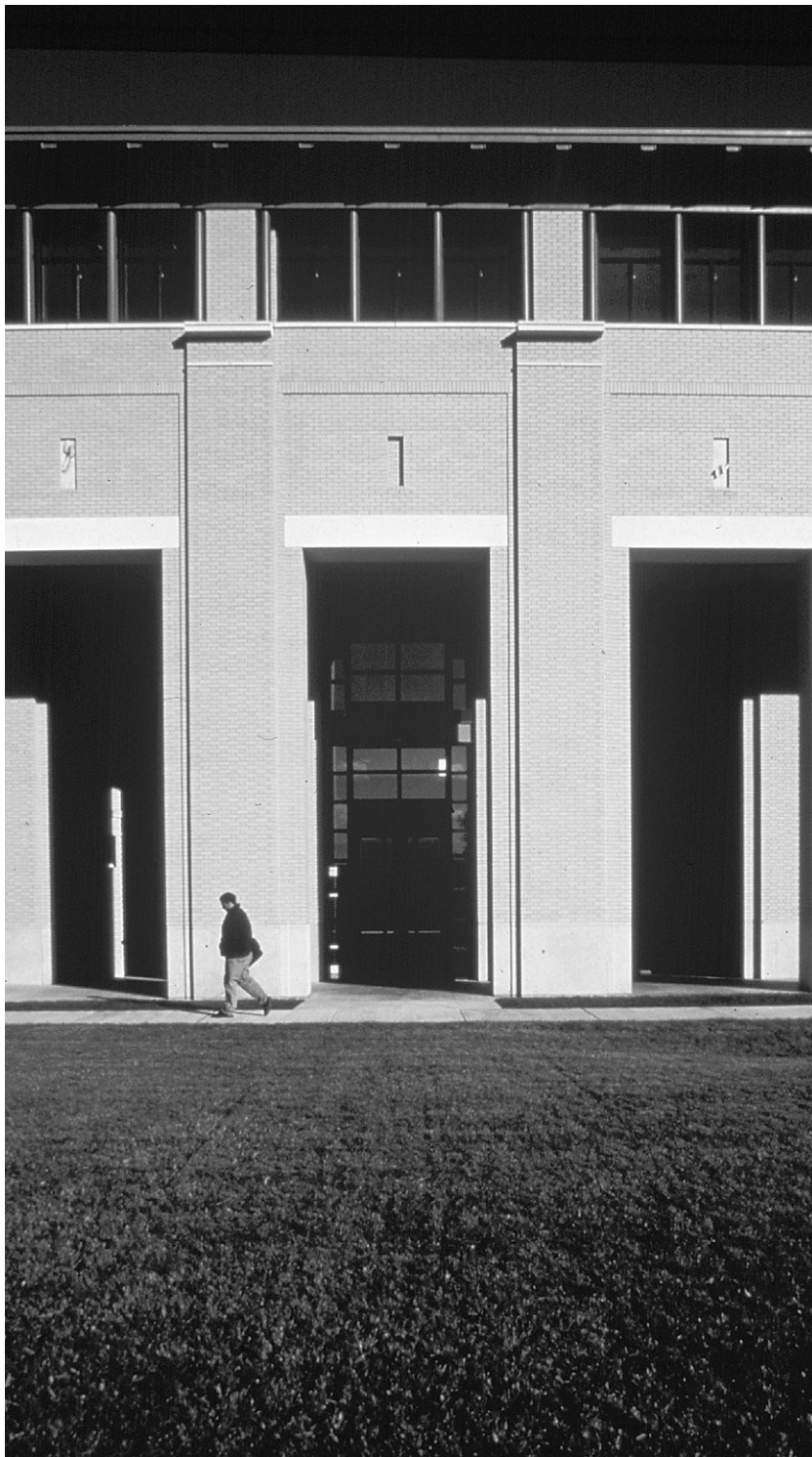
Fig. 18. CMU Arts Center
