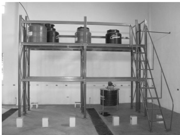
Fig.8 Estructura de la planta piloto
