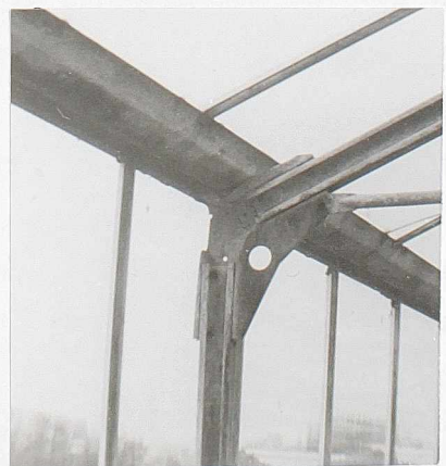
Sl. 19 Staklenici od hladno oblikovanih U profila sa vezom rigle i stuba
