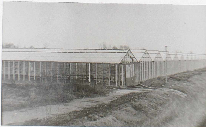
Sl. 19 Staklenici od hladno oblikovanih U profila sa vezom rigle i stuba
